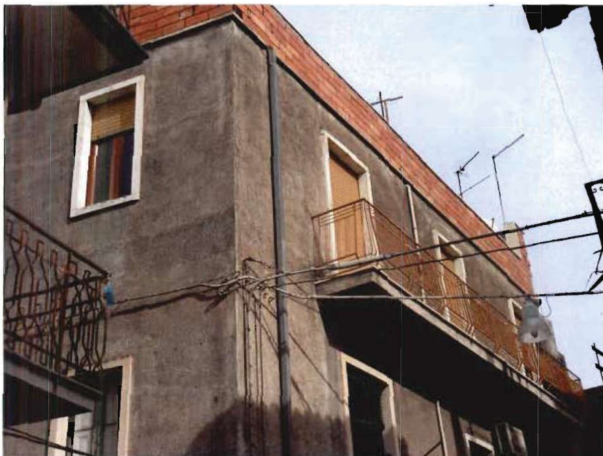
FO-2- VISTA DEL BALCONE SU VIA TRUGLIO, A CUI SI AFFACCIANO TUTTE LE STANZE
