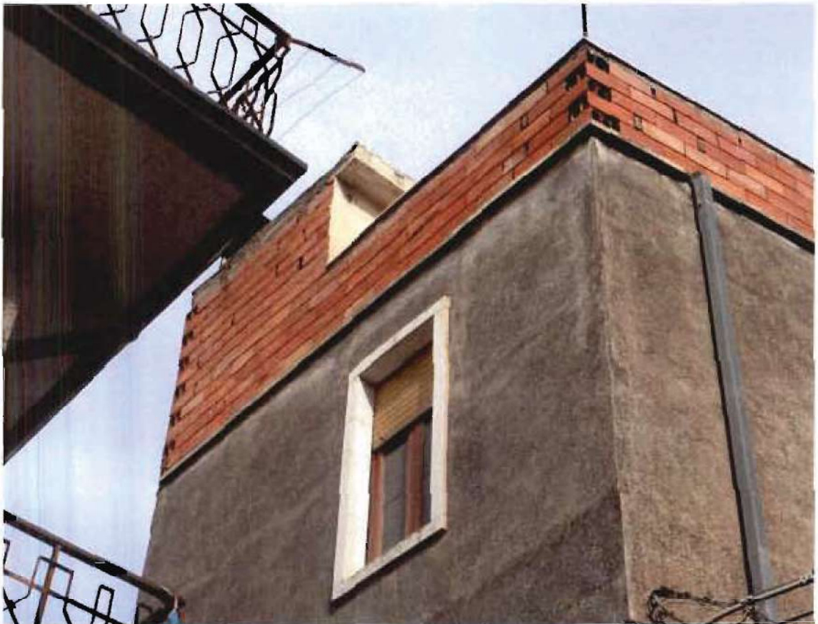
FO-21-PARTICOLARE DELLA SOPRAELEVAZIONE DI UNA PORZIONE DELLA TERRAZZA
