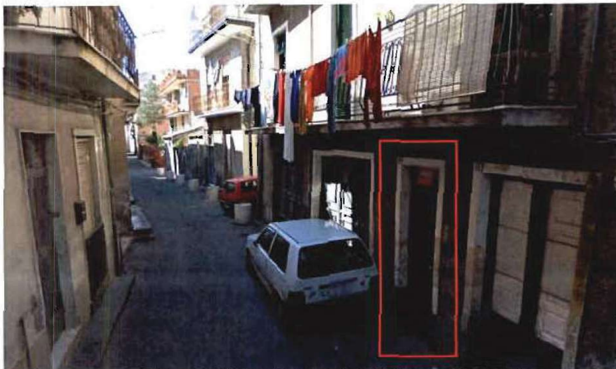
FO-1- INGRESSO ALLO STABILE IN VIA TRUGLIO 87
