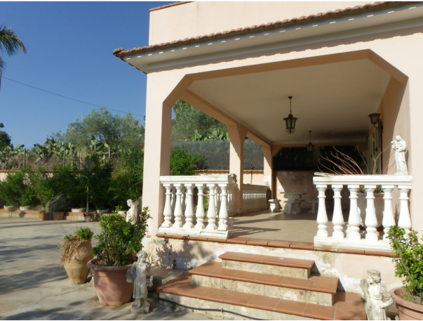
3. Vista porticato frontale (part.396)
