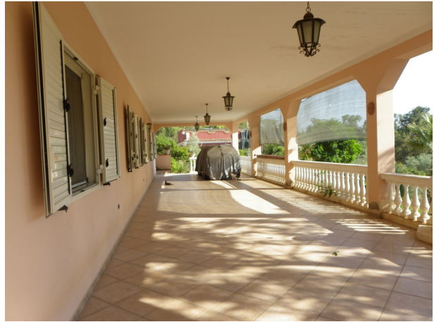
4. Vista porticato laterale (part.396)
