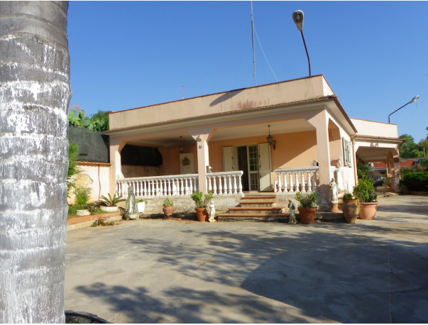
1. Vista fabbricato - Piano terra (part.396)
