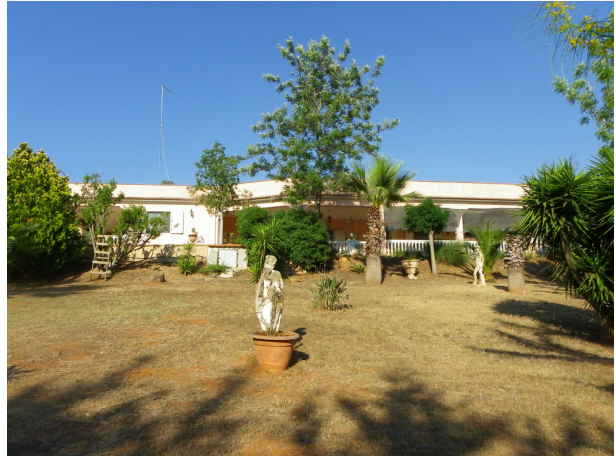
2. Vista fabbricato - Piano terra (part.396)
