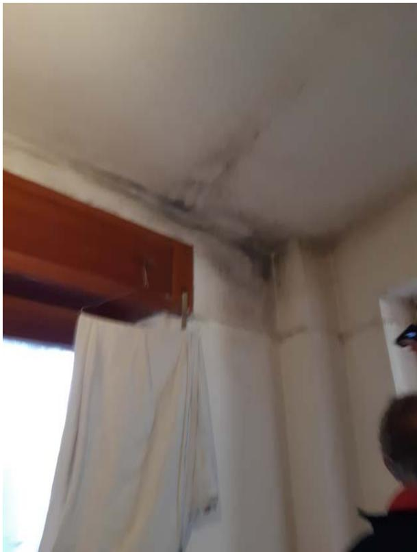
Figura 23 - Efflorescenze nel bagno
