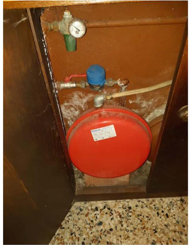
**Figura 42 - contatore acqua e vecchio impianto di riscaldamento**
