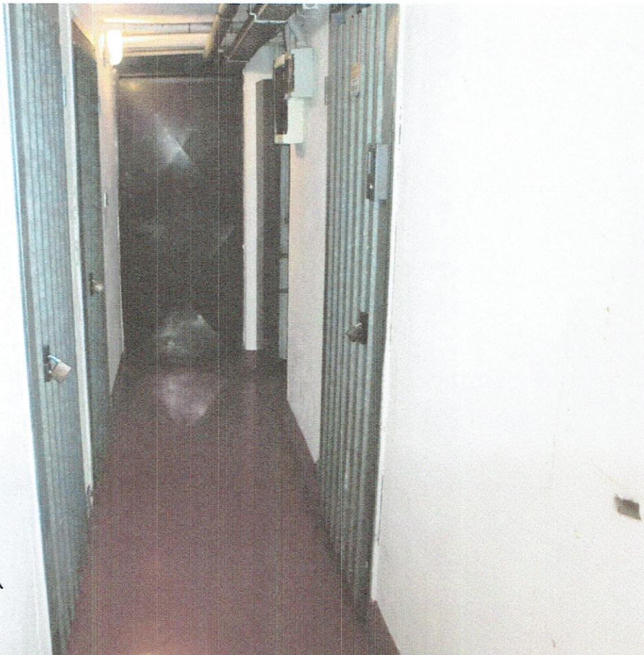
ACCESSO ALLA CANTINA
