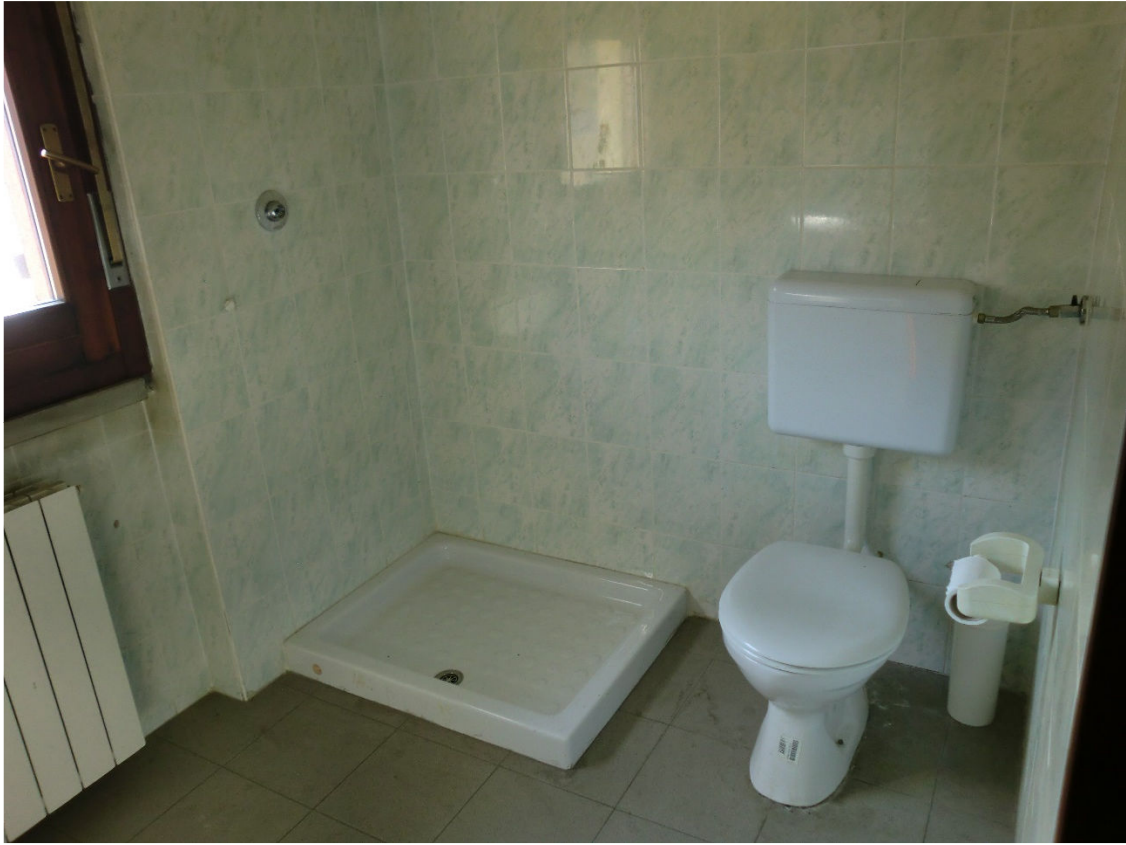
FOTO DEL SERVIZIO IGIENICO
