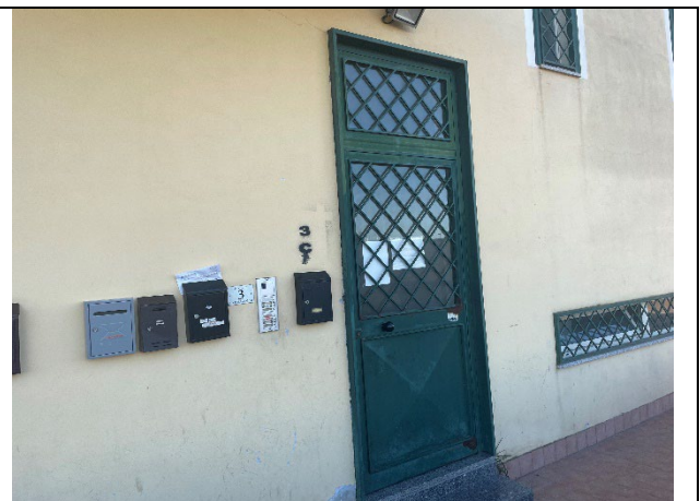
Accesso al vano scala "C" –sub 5
