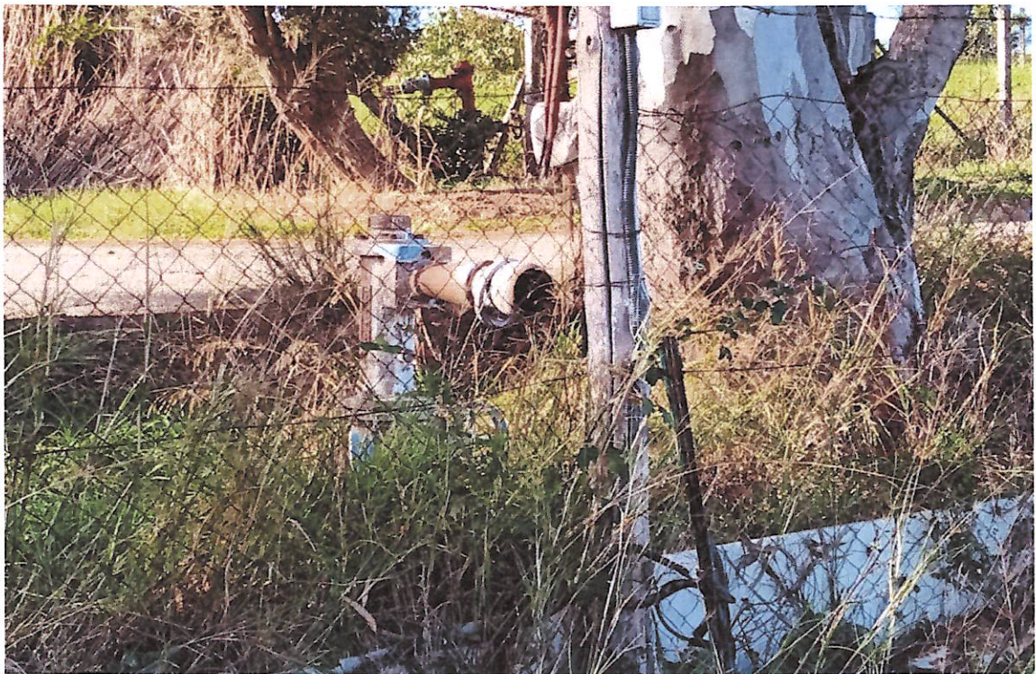
Foto 14 – presa d'acqua consortile posta vicino al cancello
