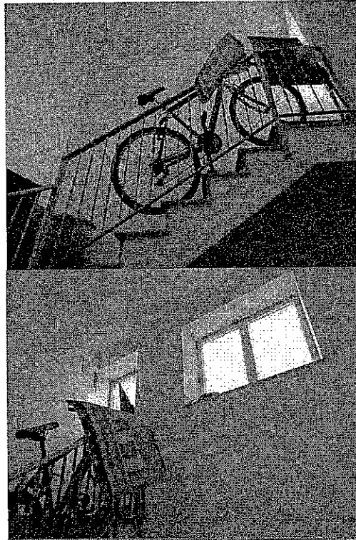
Fig. A3S.4 - Ultima Rampa: ingr. terrazzo piano 3°
