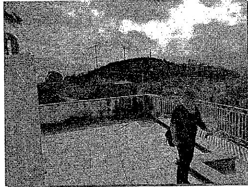
Fig. A33.2 - Vista terrazza in direzione Sud
