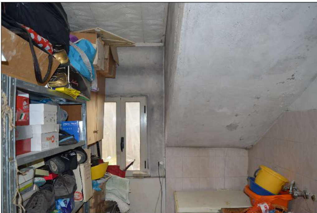
Foto 18: Fig. 224 - Part. 441 – corpo principale: vano aggiuntivo sul retro, lavanderia e ripostiglio
