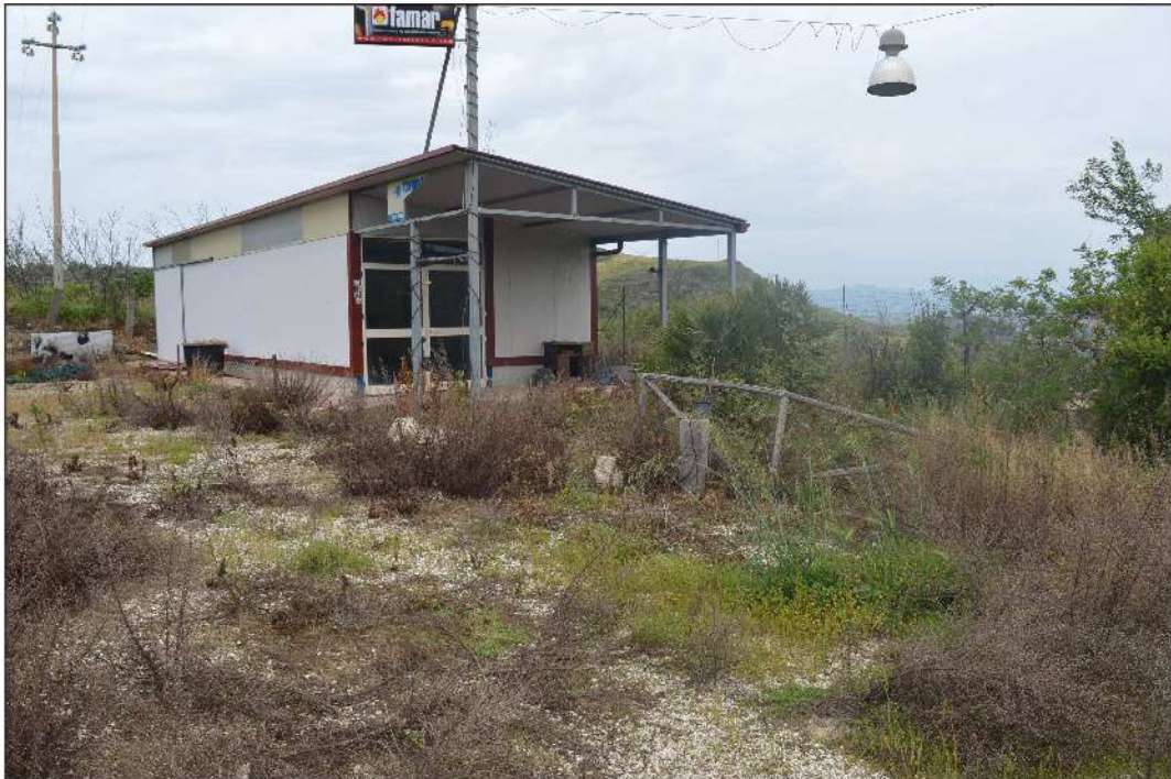
Foto 35: Fig. 224 - Part. 268 – vista parte nord con ubicazione di fabbricato in acciaio
