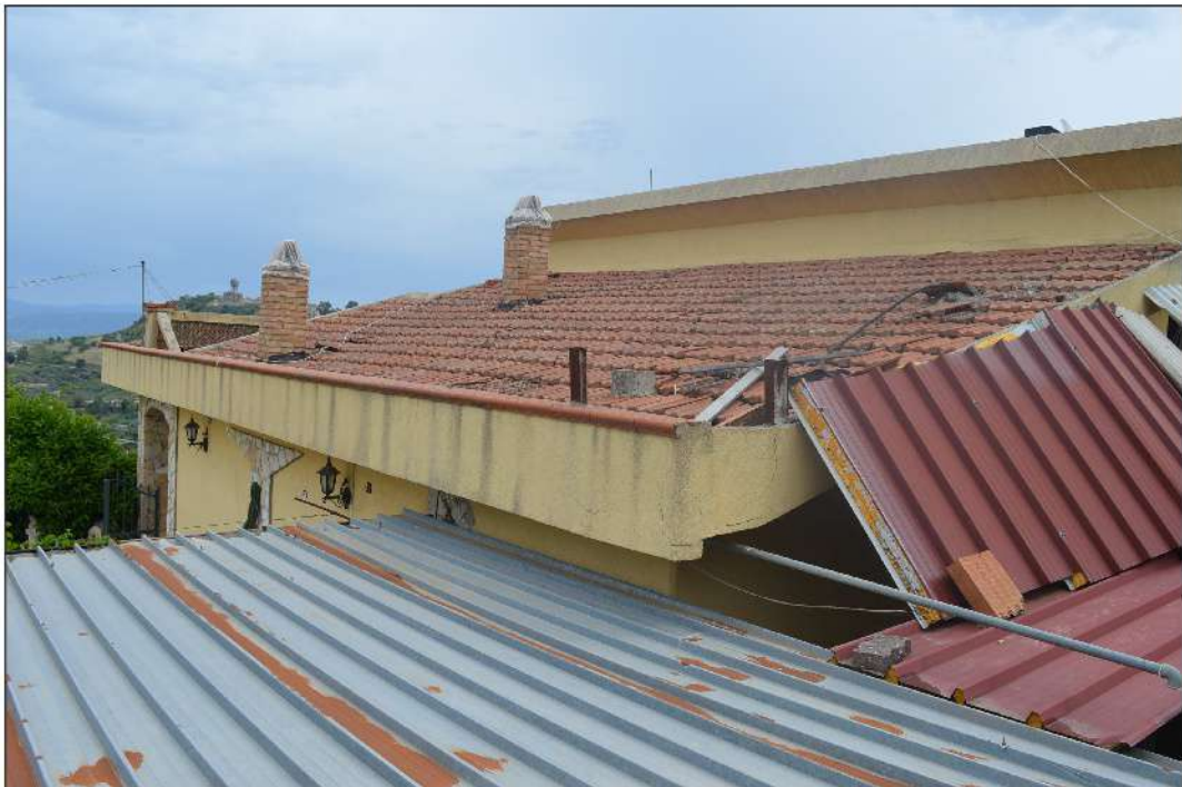
Foto 6: Fg. 224 - Part. 441 – vista fabbricato lato sud/ovest e tettoia su cortile
