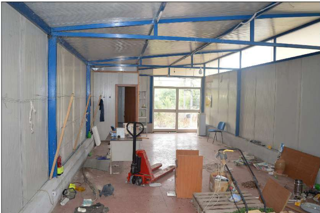
Foto 38: Fg. 224 - Part. 268 – vista interna fabbricato in acciaio all'interno della part. 268
