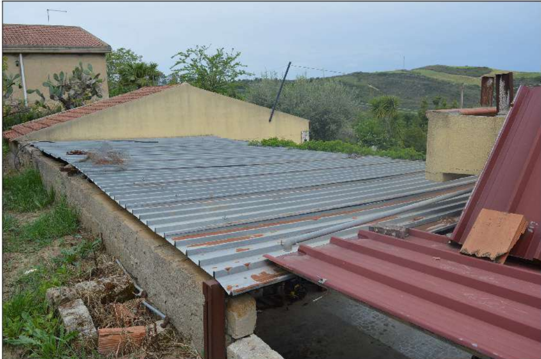
Foto 7: Fg. 224 - Part. 441 – vista da sud corpo secondario destinato a garage/magazzino e tettoia su cortile
