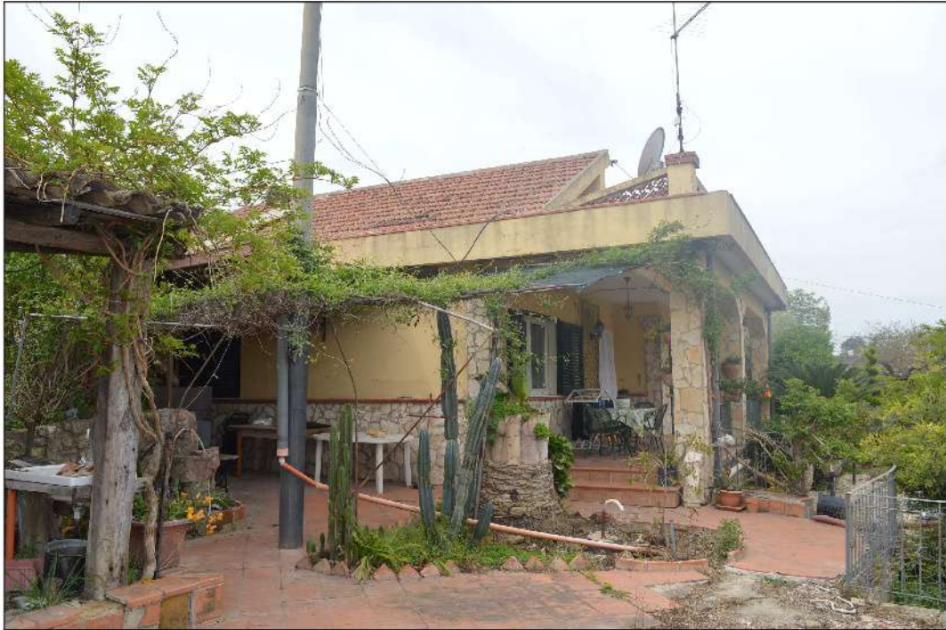
Foto 1: Fg. 224 - Part. 441 – vista fabbricato corpo principale lato nord/est
