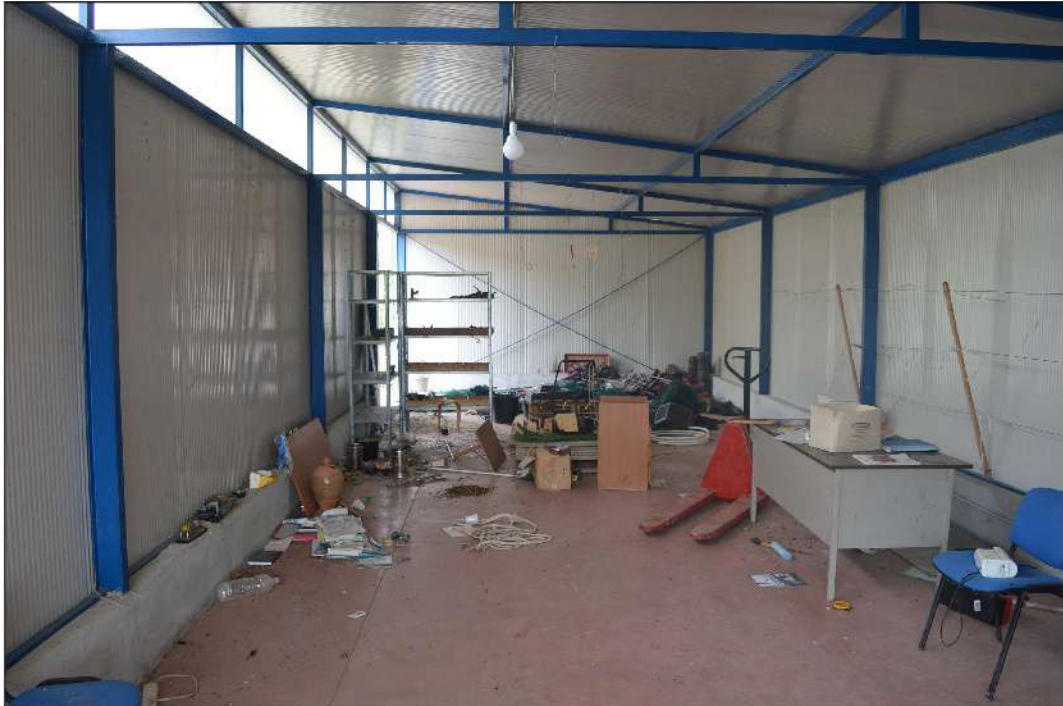
Foto 37: Fg. 224 - Part. 268 – vista interna fabbricato in acciaio all'interno della part. 268
