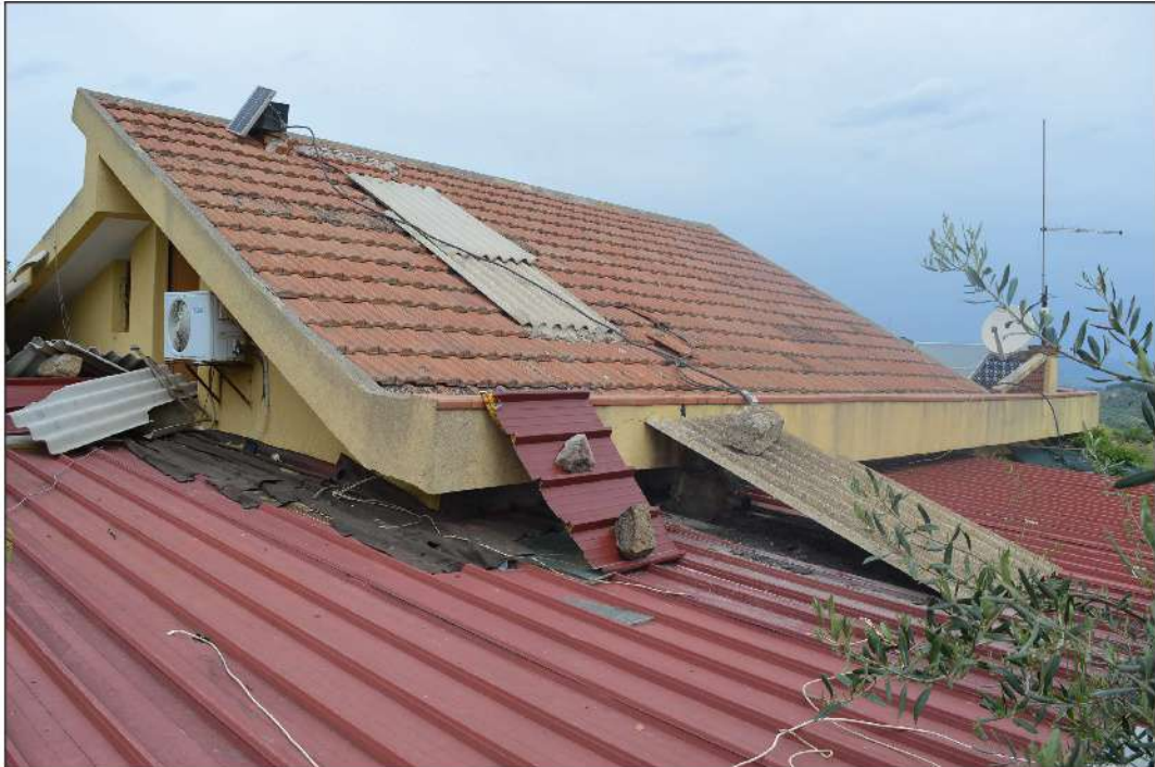
Foto 5: Fg. 224 - Part. 441 – vista fabbricato lato sud/est: corpo principale e copertura vani aggiuntivi
