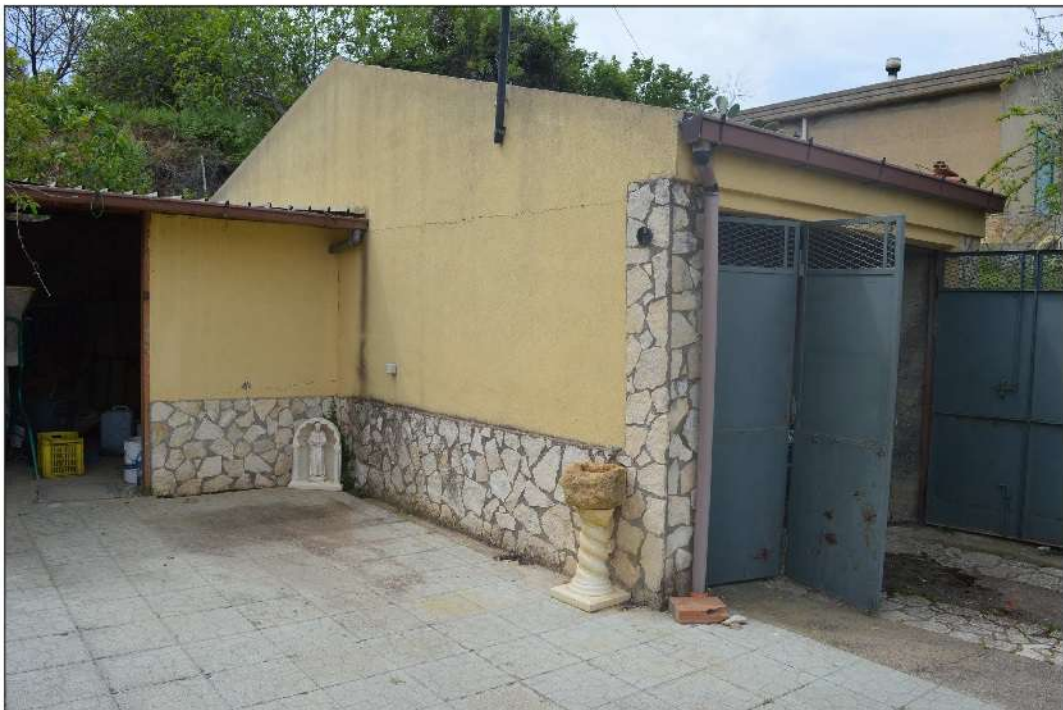
Foto 24: Fg. 224 - Part. 441 – vista corpo secondario destinato a garage/magazzino e tettoia
