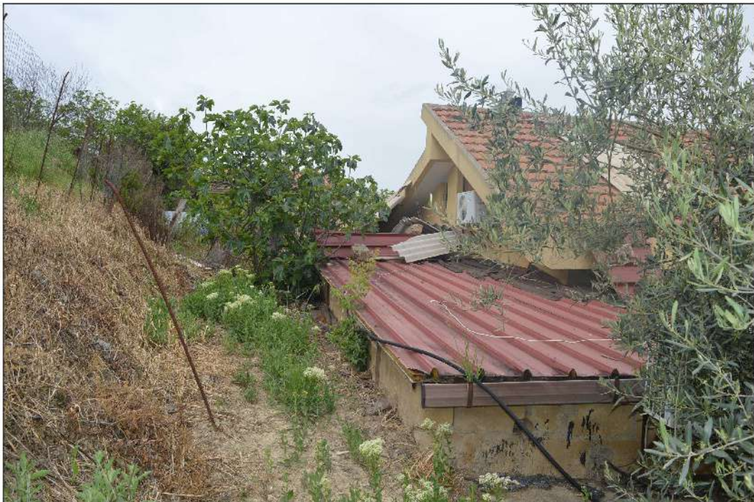
Foto 4: Fg. 224 - Part. 441 – vista fabbricato lato sud/est: corpo principale e copertura vani aggiuntivi
