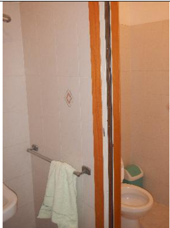
Foto n 8: "Bagno" P.T
