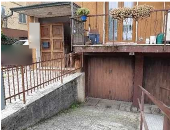
Vista della rampa di accesso all'autorimessa sotto strada
