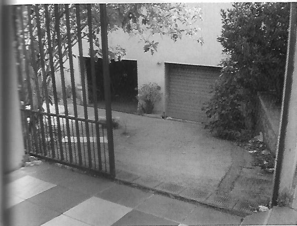
Foto 01 - locale garage - sub 2
