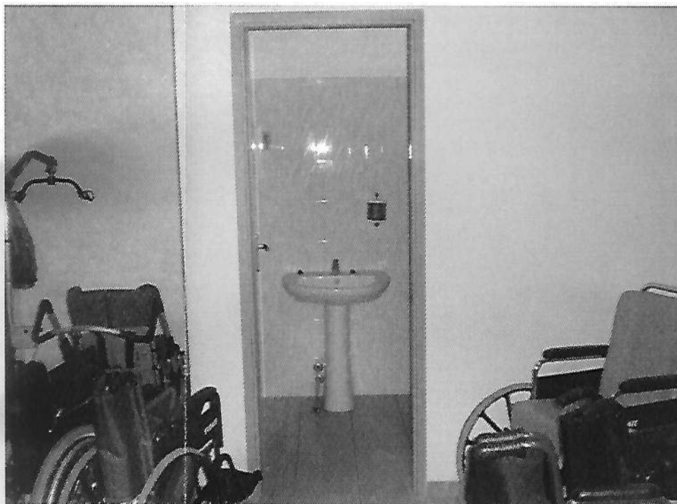
Foto 15 – locale deposito commerciale – sub 5
