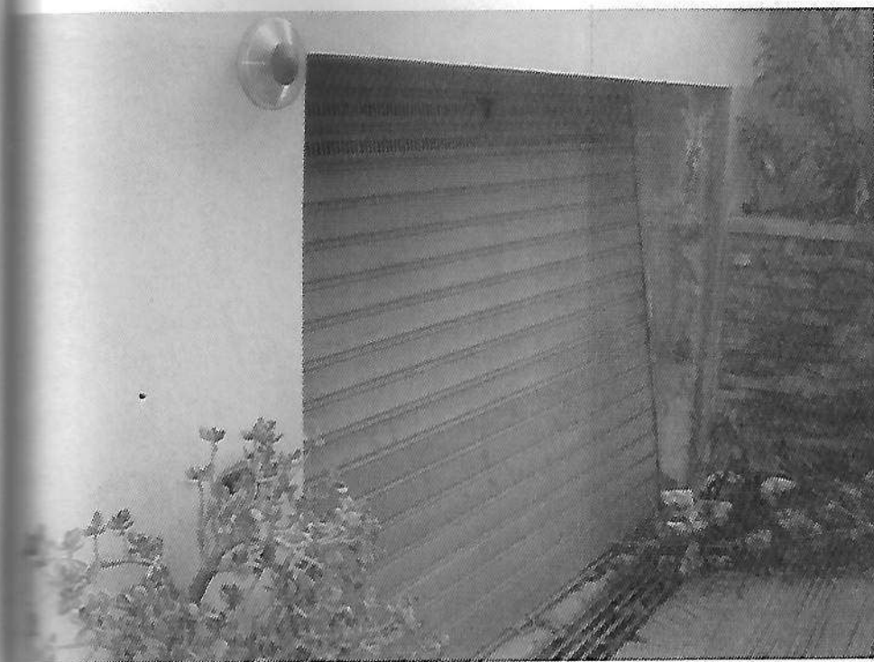
Foto 04 - locale garage - sub 2
