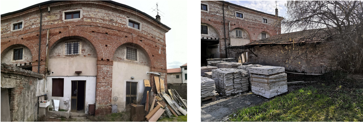
Figura 3. Foto esterne immobile.
