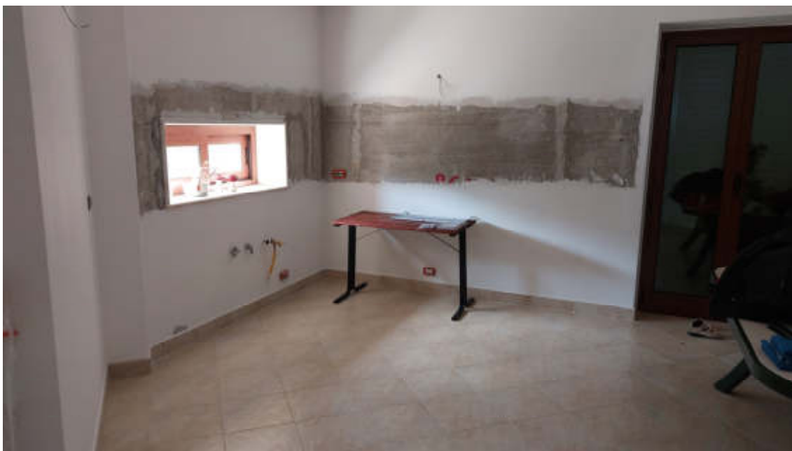
Foto 16 - interni alloggio custode – piano terra;
