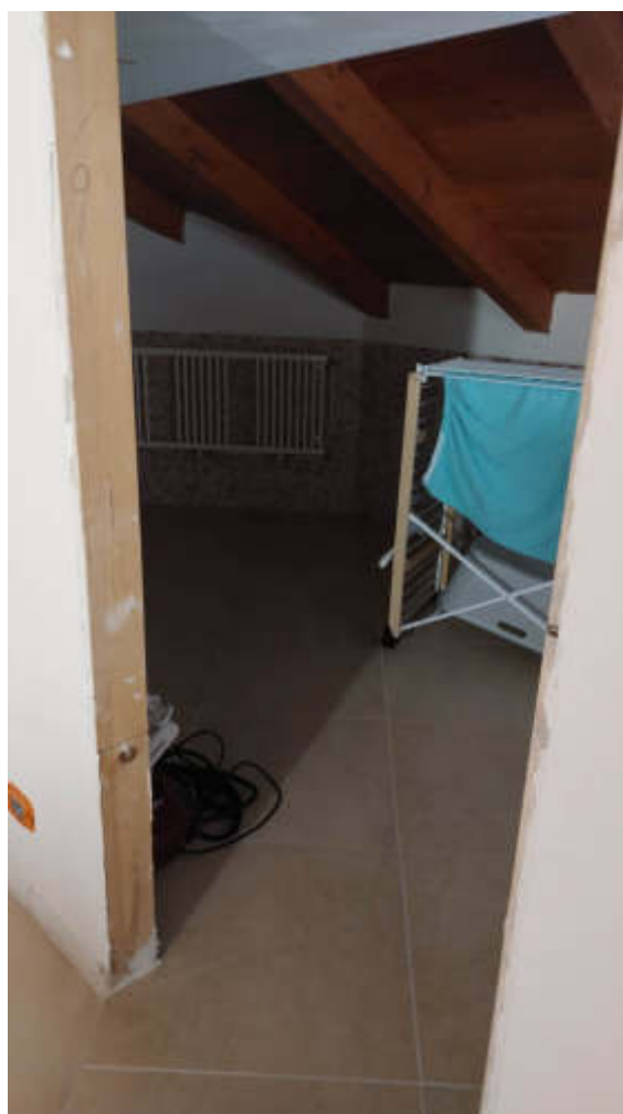
Foto 20 - interni alloggio custode – piano soppalco;
