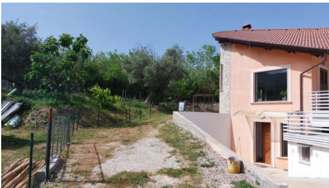
Foto 3: esterni – alloggio del custode - zona posteriore;
