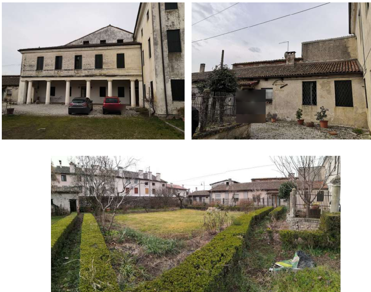
Figura 3. Foto esterne immobile.
