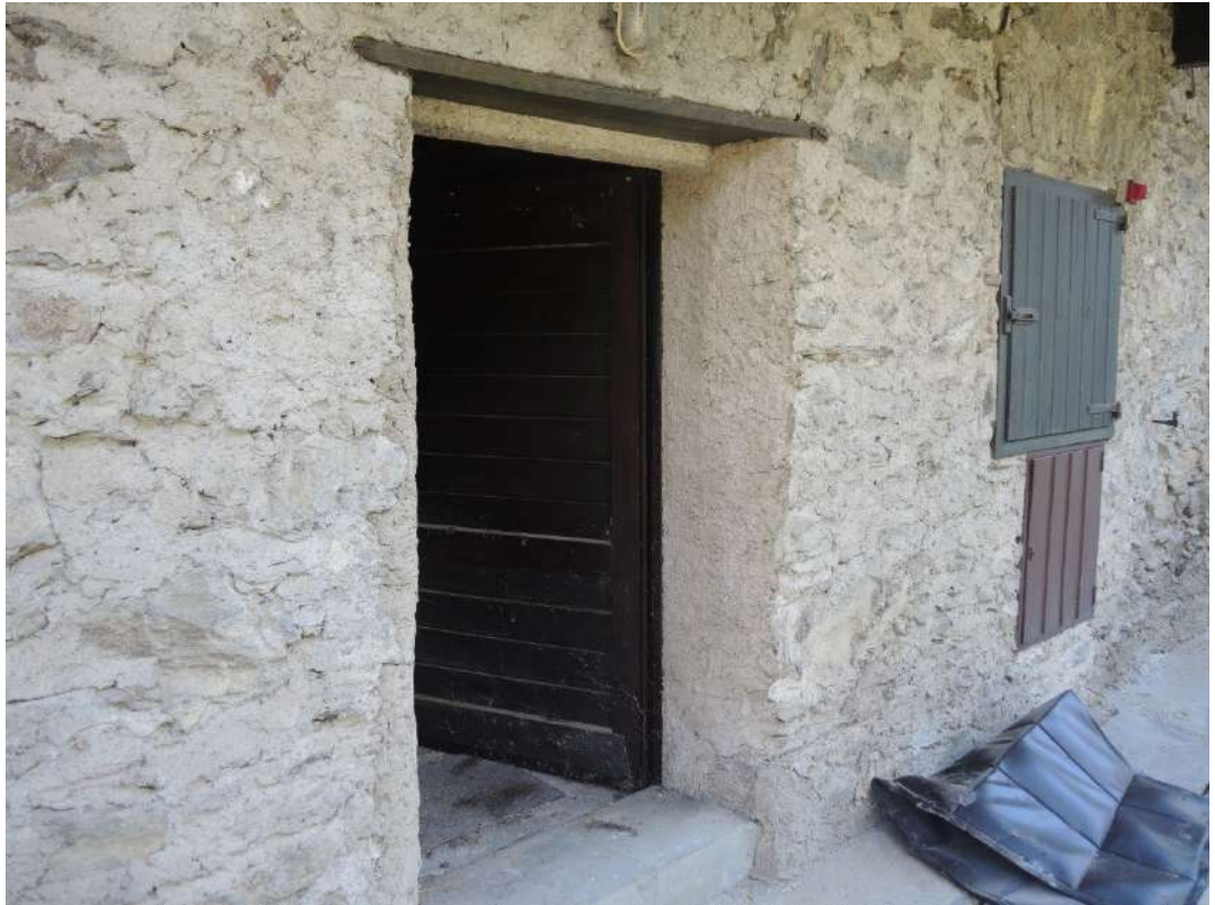
Piano terra - Accesso locale lavanderia e caldaia
