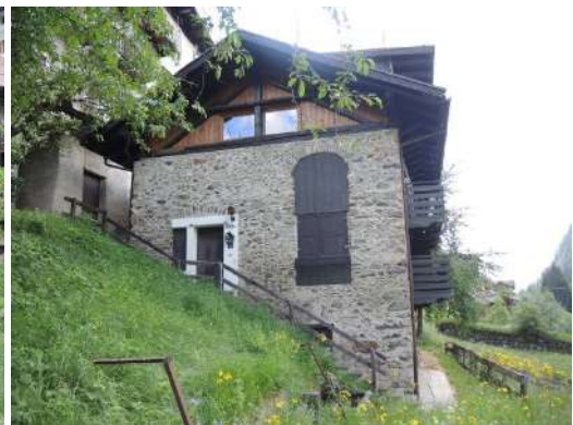
Edificio p.ed. 624 – prospetto ovest
