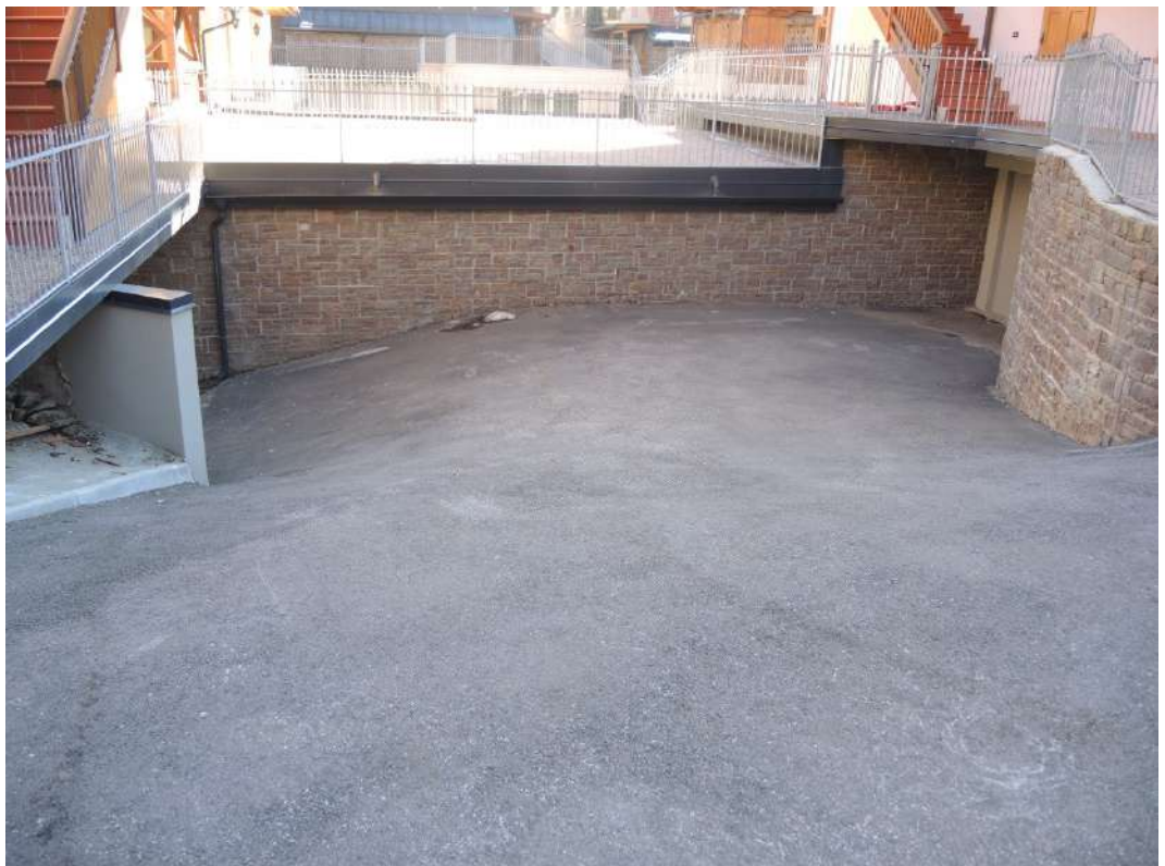
Rampa bitumata p.f. 769/1 di acceso ai piani interrati delle pp.edd. 581 e 573
