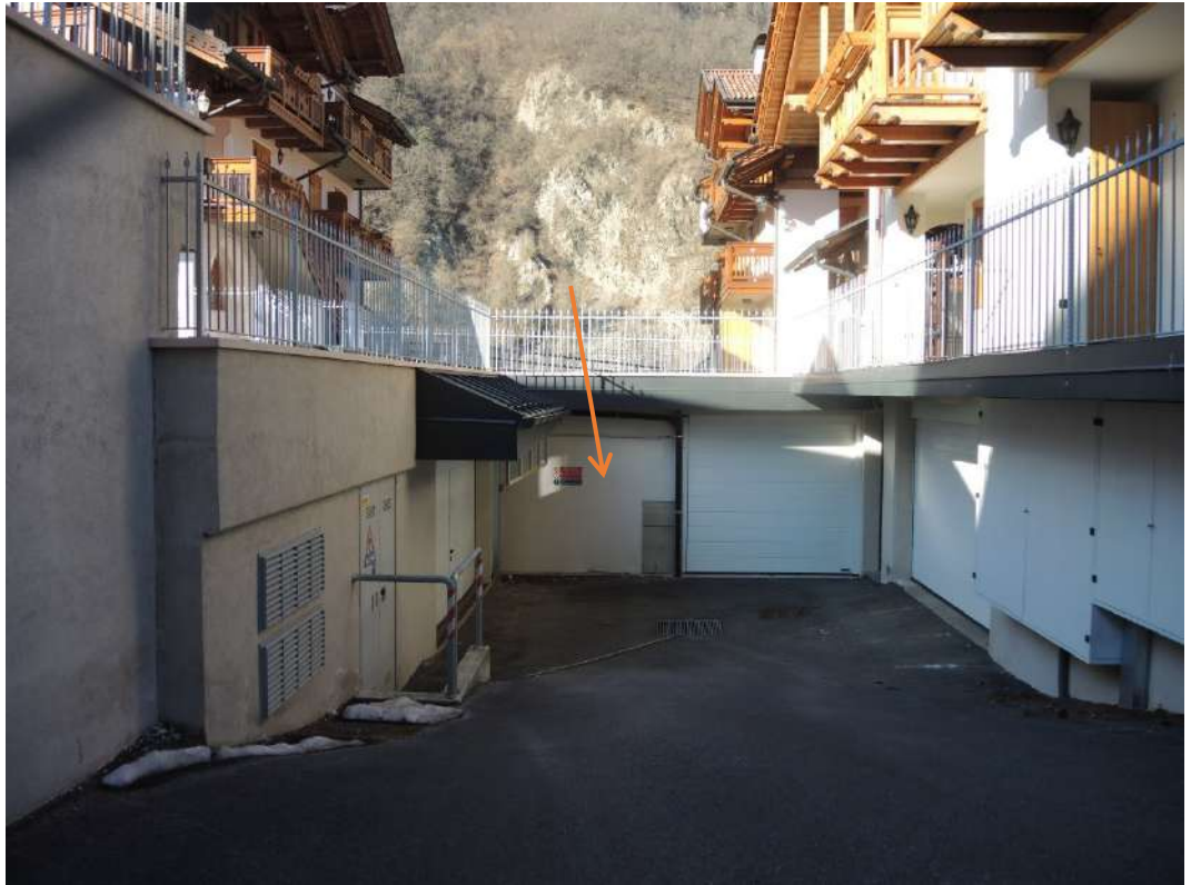
Edificio p.ed. 581 posto auto p.m. 16 tamponato
