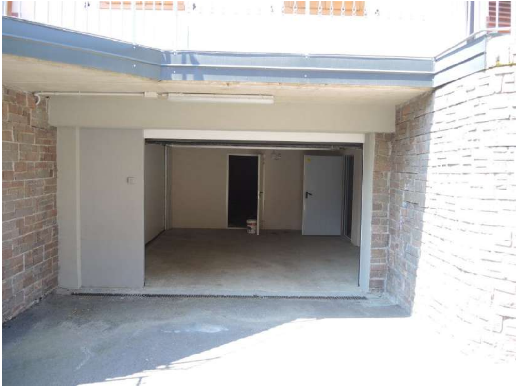
Edificio p.ed. 573 Adito p.m. 35 e vista su corsia di manovra comune
