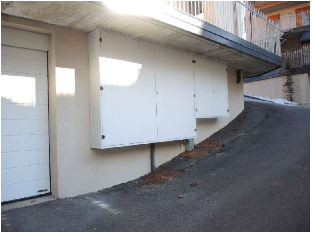
Edificio p.ed. 605 vano contatori p.m. 9
