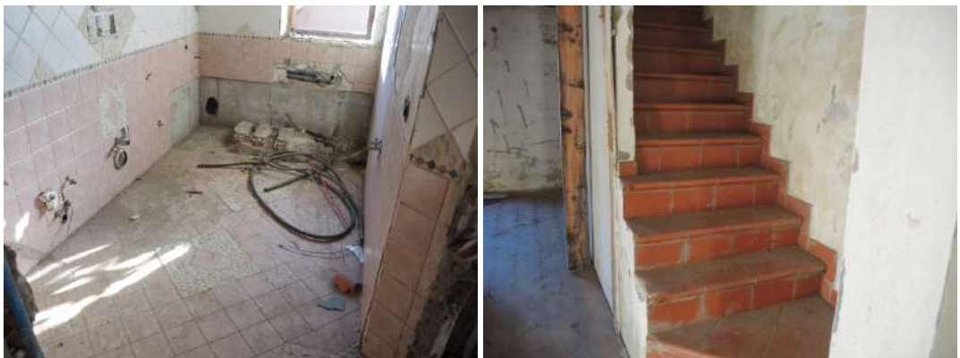
Bagno a piano terra e scala di accesso al piano primo edificio p.ed. 573 p.m. 36
