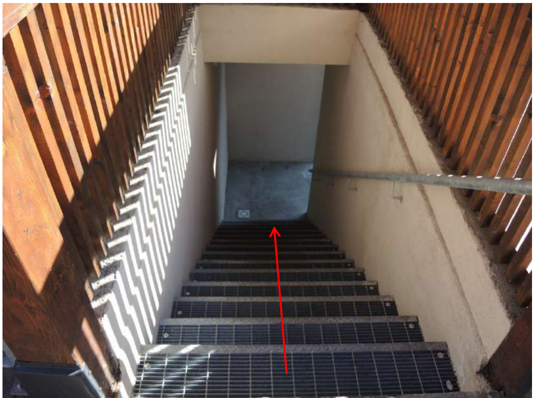
Edificio p.ed. 605 scala e vano scala ascendente fino al pianoterra-rialzato p.m. 9
