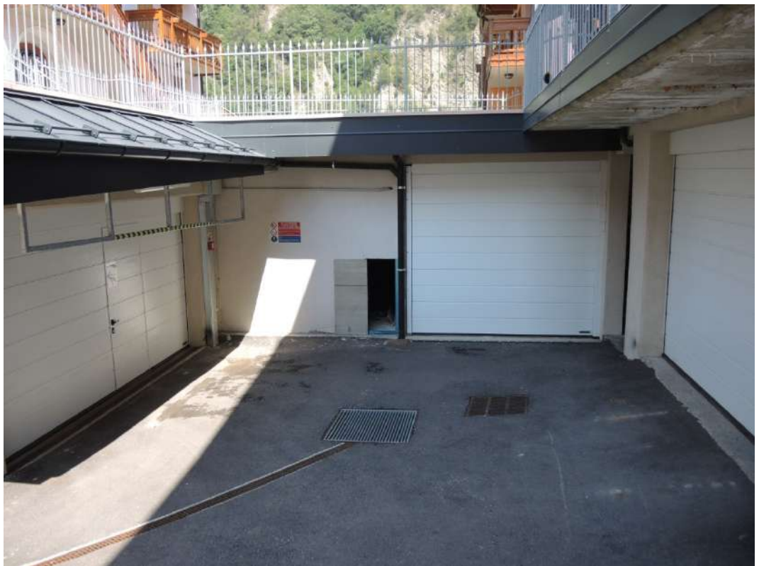
Edificio p.ed. 581 posto auto p.m. 16 tamponato
