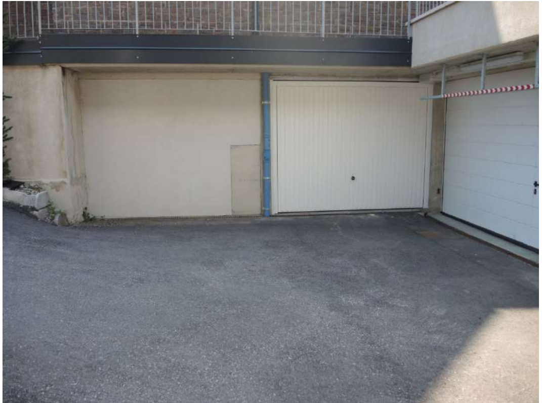
Edificio p.ed. 563 posto auto p.m. 13 tamponato
