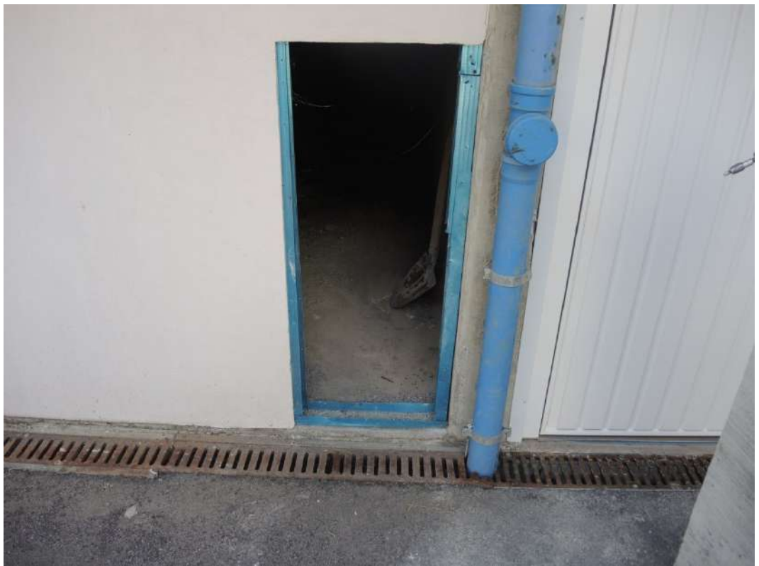
Edificio p.ed. 563 posto auto p.m. 13 tamponato
