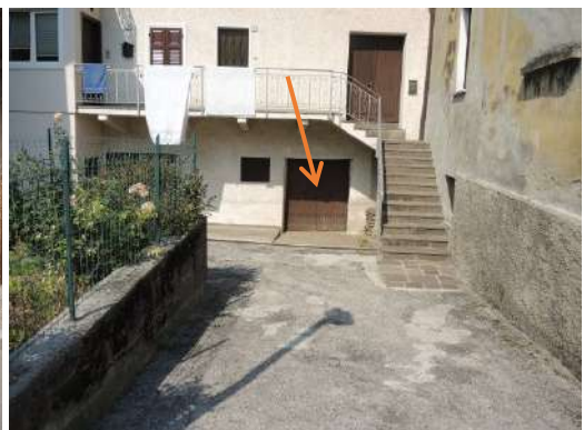
Ingresso stalla piano seminterrato
