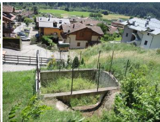
Opera di presa acqua di scorrimento superf.
