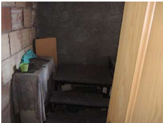
P1 – Scala soffitta
