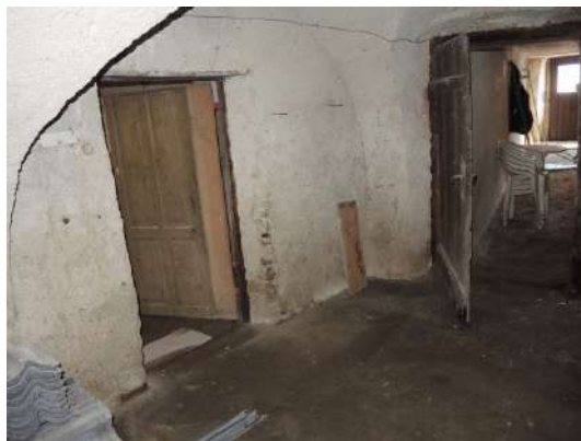
S1 – porta ingresso altro avvolto
