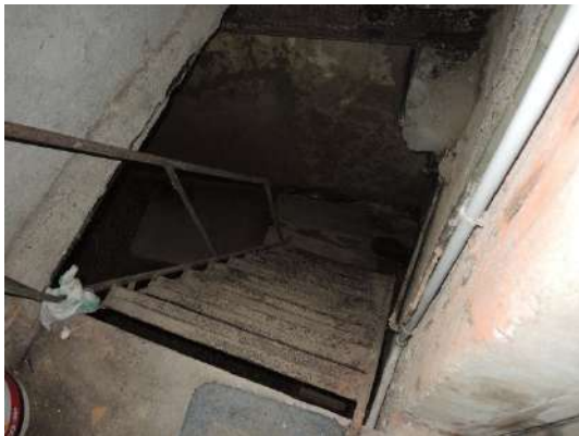
Scala di accesso piano S1
