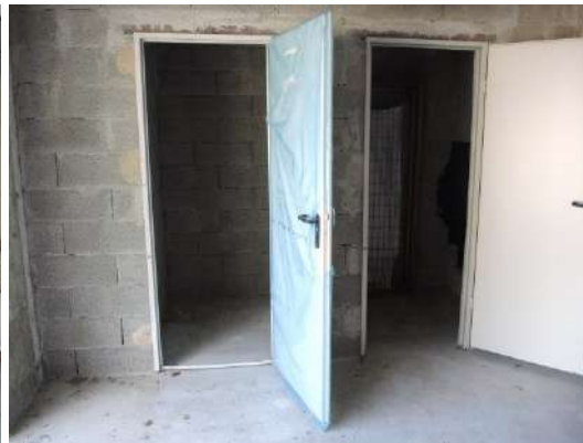
Porte di accesso alle cantine pp.mm. 30 e 31
