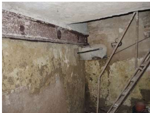
S1 – Locale corte- particolare trave
