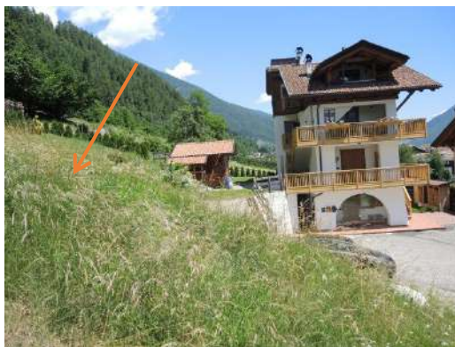
Edificio p.ed. 241 C.C. Croviana
