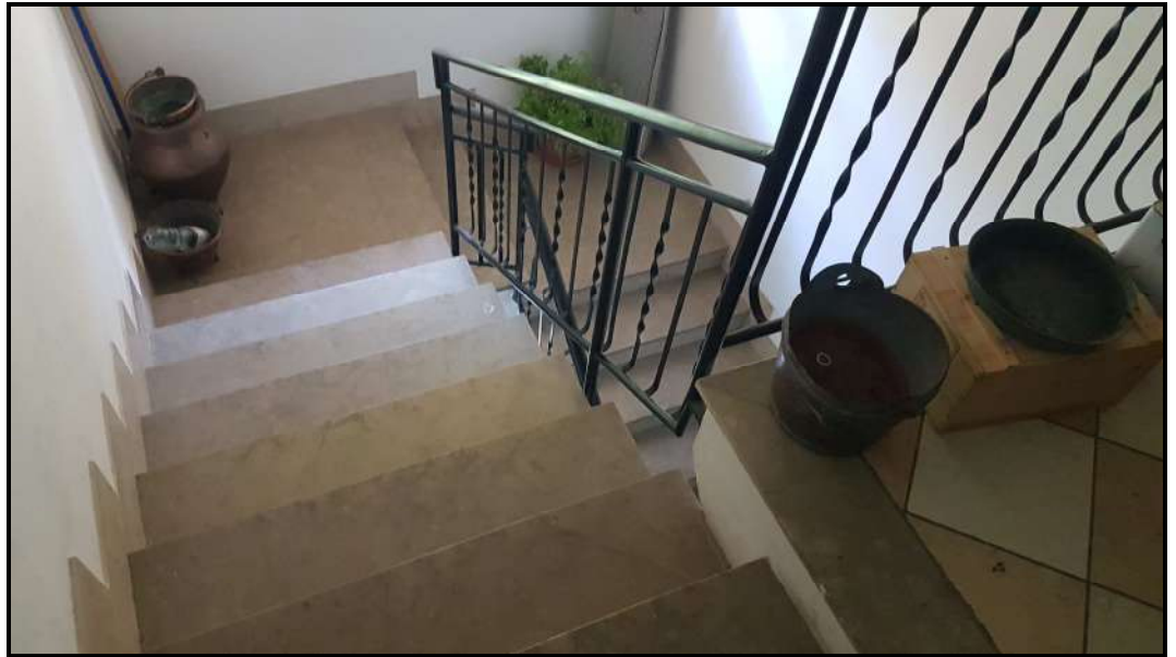
VANO SCALE (comune) – piano terra a piano secondo
