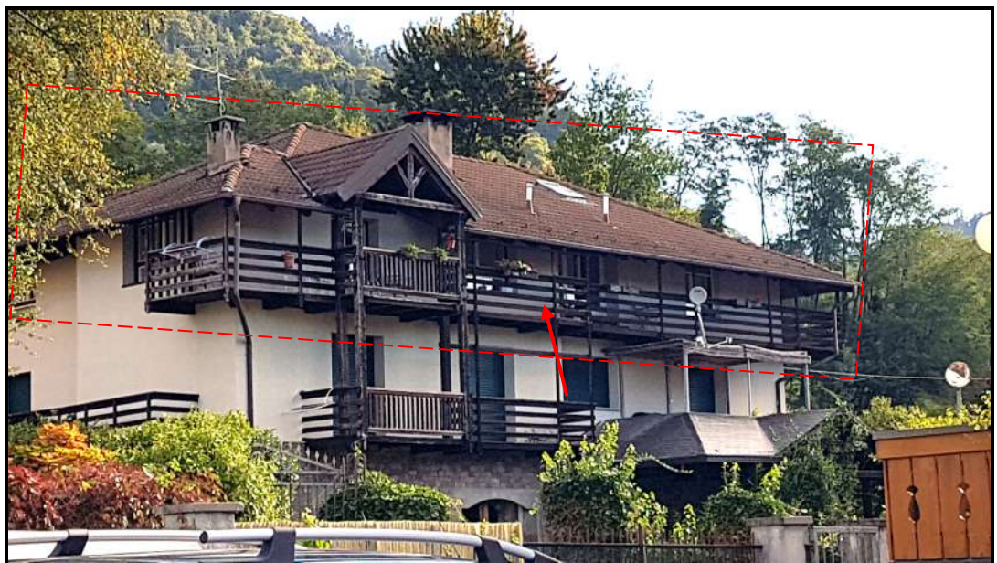
VISTA PROSPETTO SUD-OVEST
