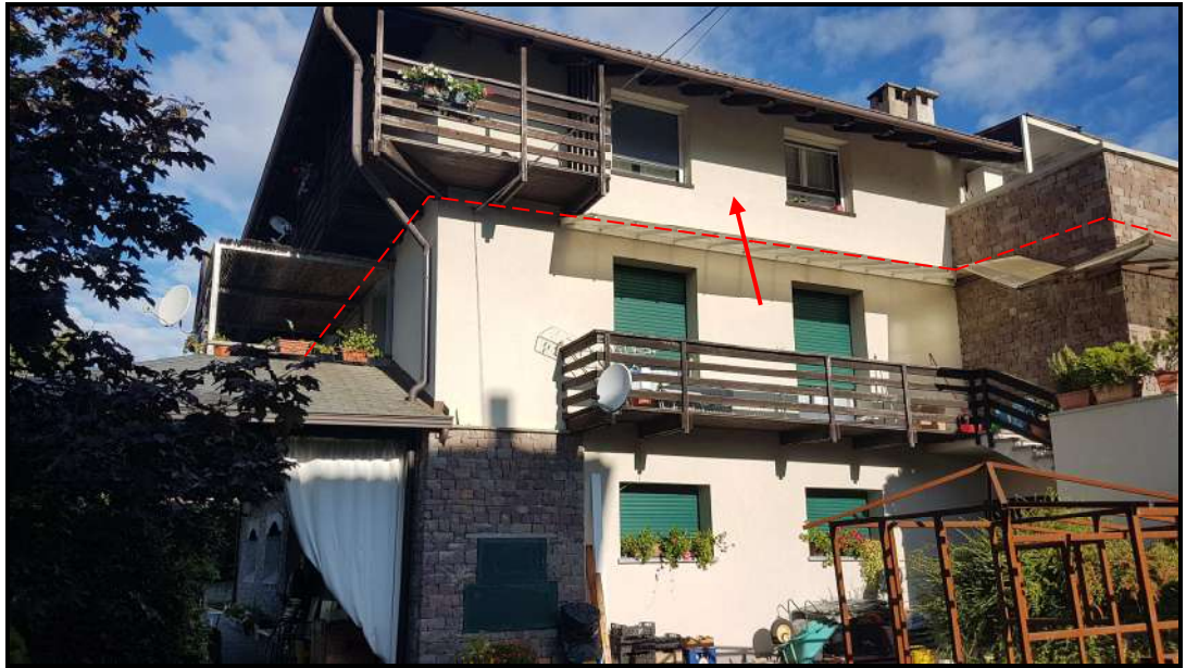
VISTA PROSPETTO SUD-EST
