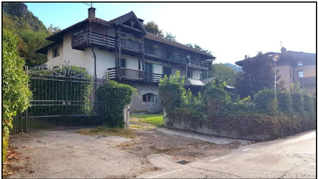
VISTA COMPLESSIVA P.ED. 291 C.C. MADRANO DA SUD-OVEST
