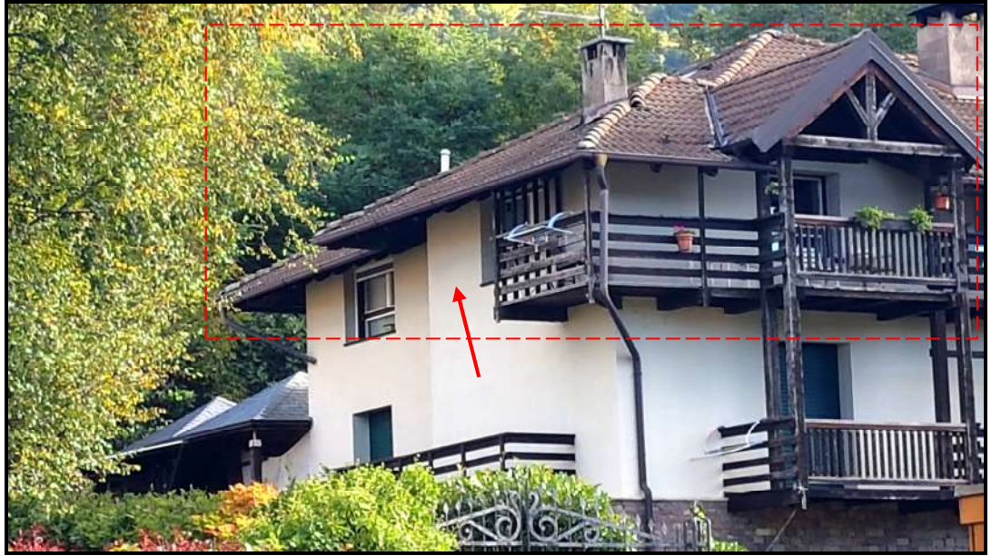
VISTA PROSPETTO NORD-OVEST
