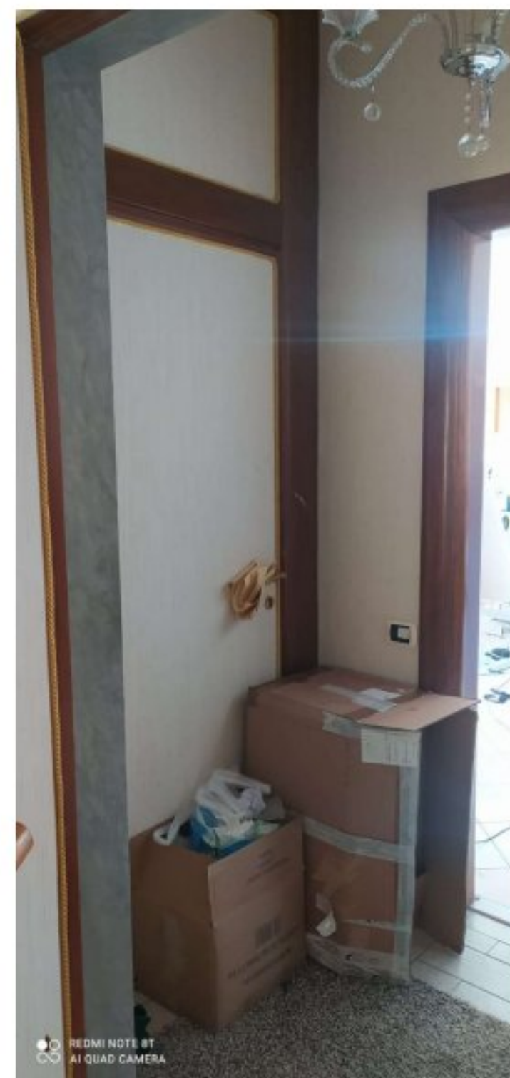
Foto 3 – accesso da scala inibito
