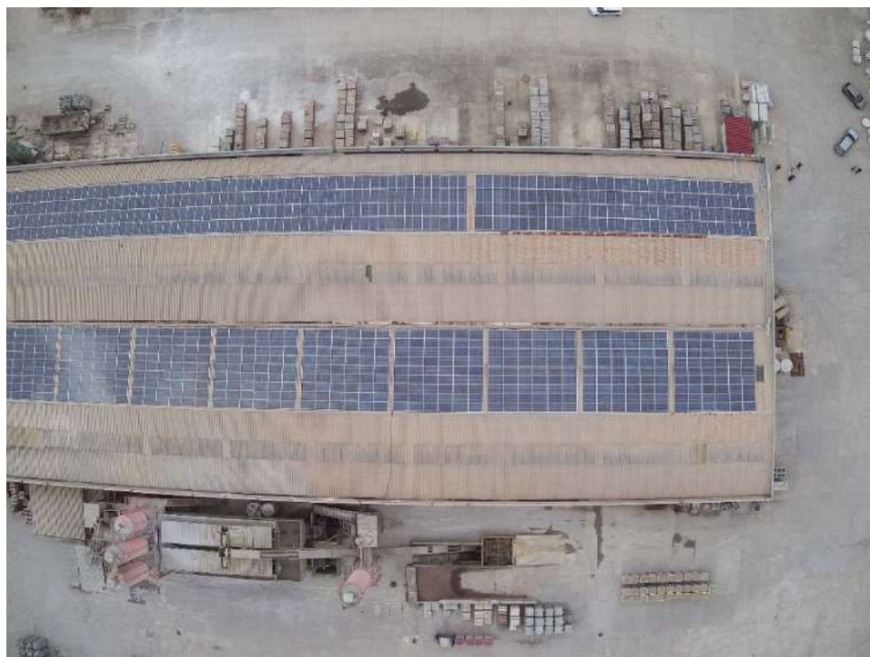
Figura 3 – Vista aerea 'impianto fotovoltaico ██████████
