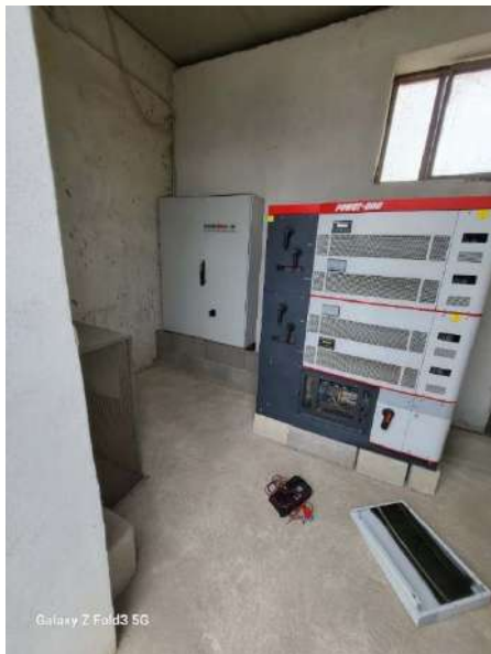
Figura 13 e 14_ Gruppo di conversione C.C./C.A e Quadro MT
