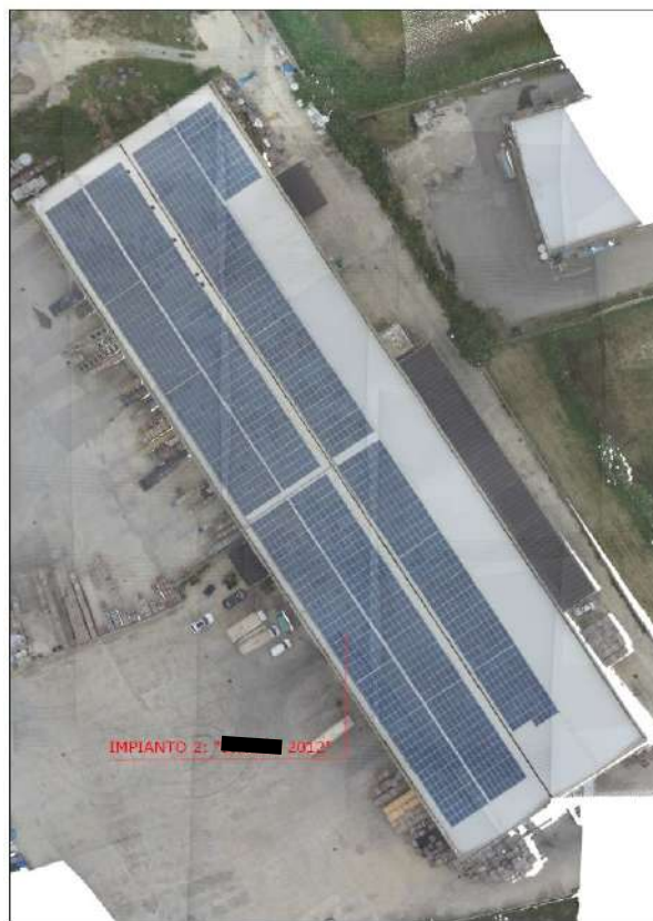
Figura 2 - Immagine dall'alto del corpo di fabbrica su cui è installato l'impianto fotovoltaico [redacted] 12"
