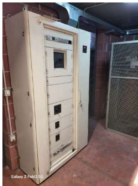
Figura 15 e 16_ Gruppo di conversione C.C./C.A e Quadro MT
