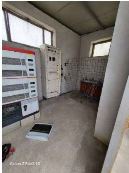
Figura 13 e 14_ Gruppo di conversione C.C./C.A e Quadro MT
