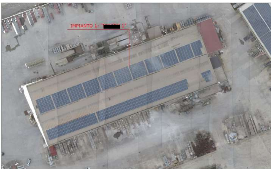
Figura 1 – Immagine dall'alto del corpo di fabbrica su cui è installato l'impianto fotovoltaico [REDACTED]
