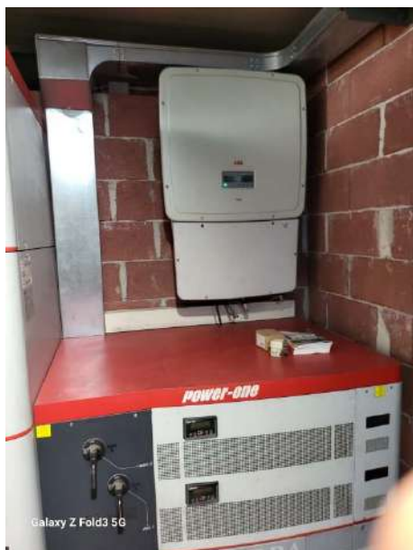
Figura 15 e 16_ Gruppo di conversione C.C./C.A e Quadro MT
