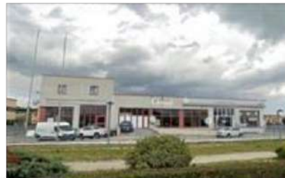
vista sud da via dell'Industria
