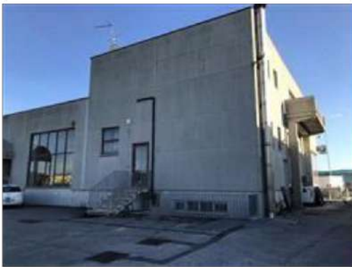
vista nord-ovest blocco uffici-appartamento
