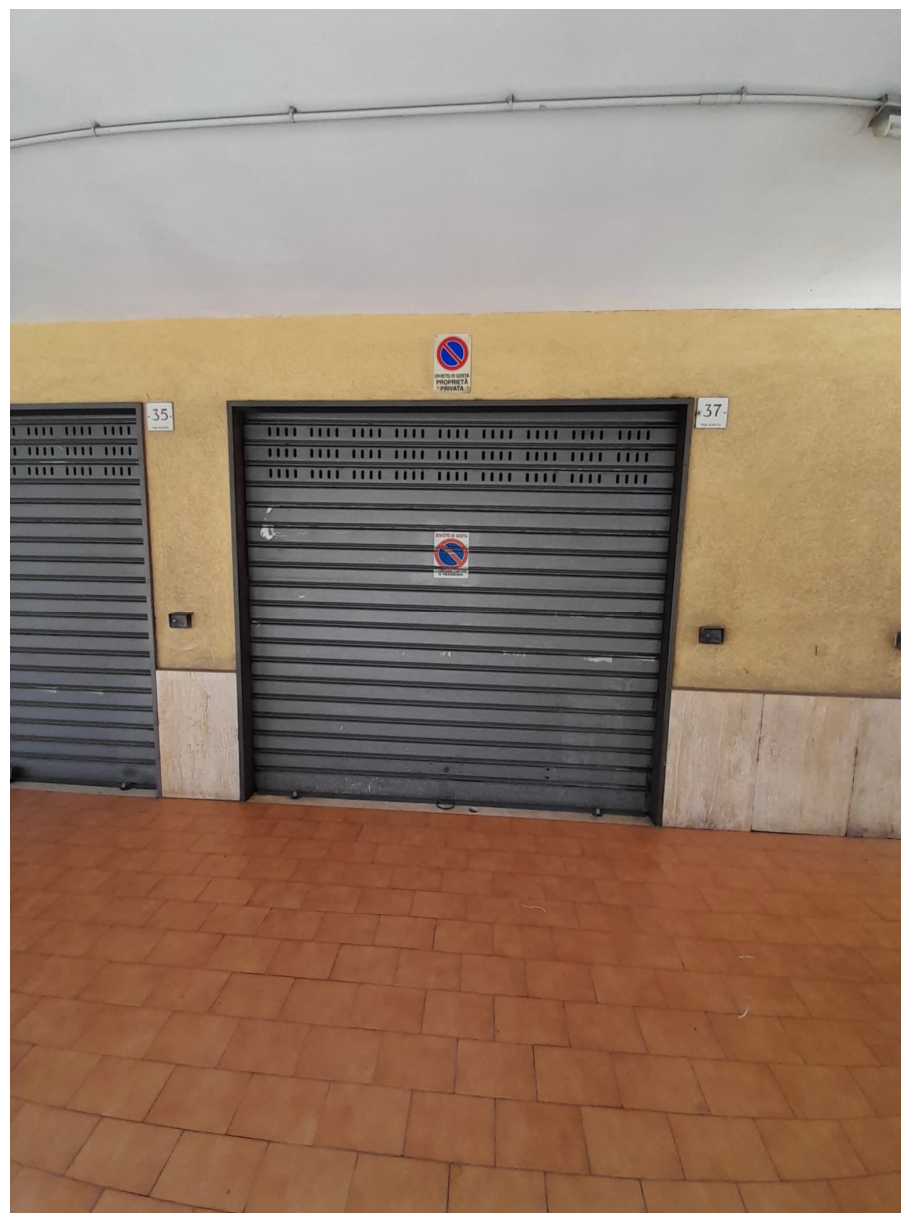
Foto n°14 - Vista esterna del garage
