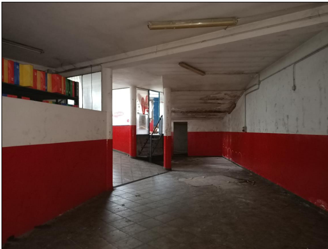
Fotografia 9: Vista zona deposito provvisorio gomme
