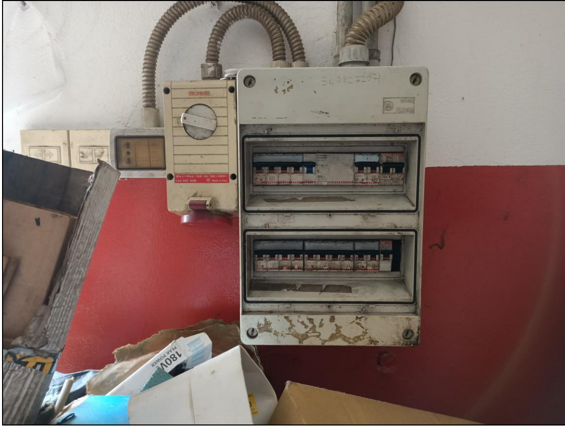
Fotografia 15: Particolare impianto elettrico
