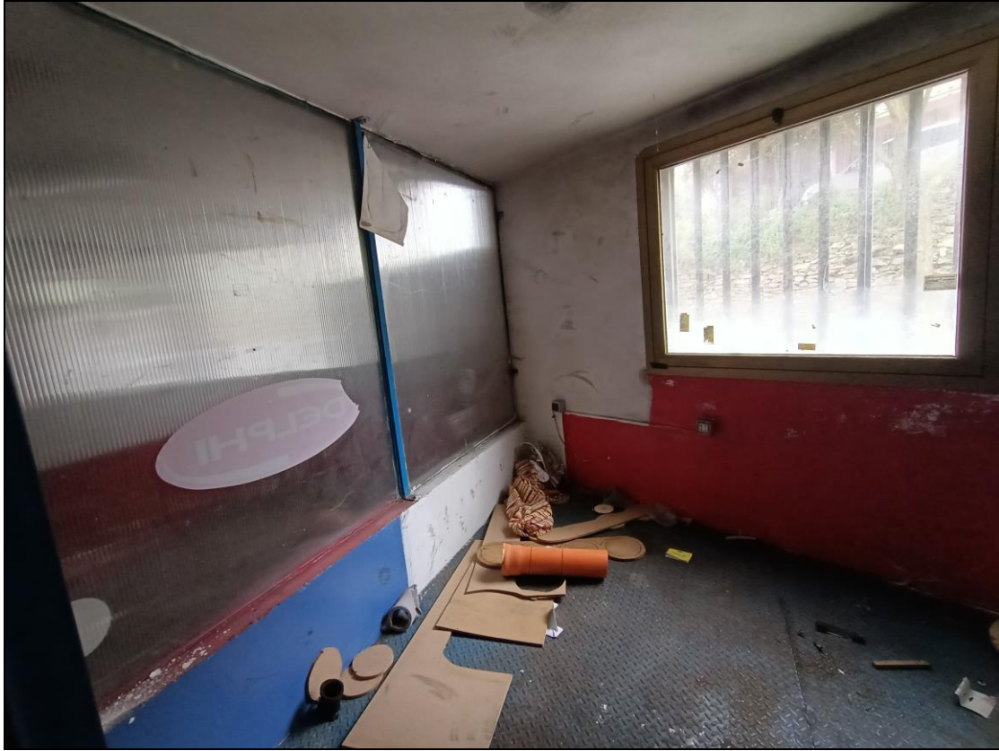
Fotografia 12: Vista locale su soppalco, zona accettazione.
