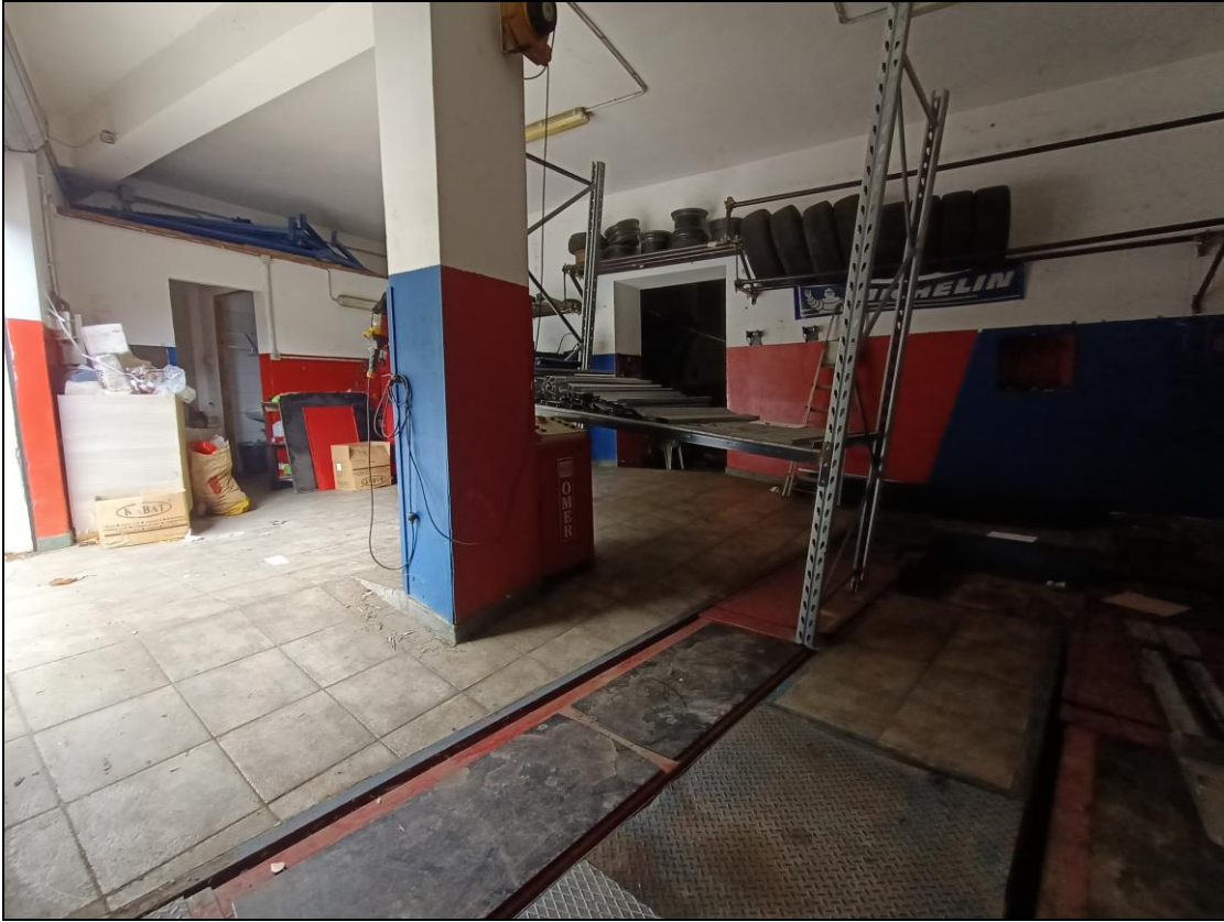
Fotografia 3: Vista dell'ambiente officina esistente
