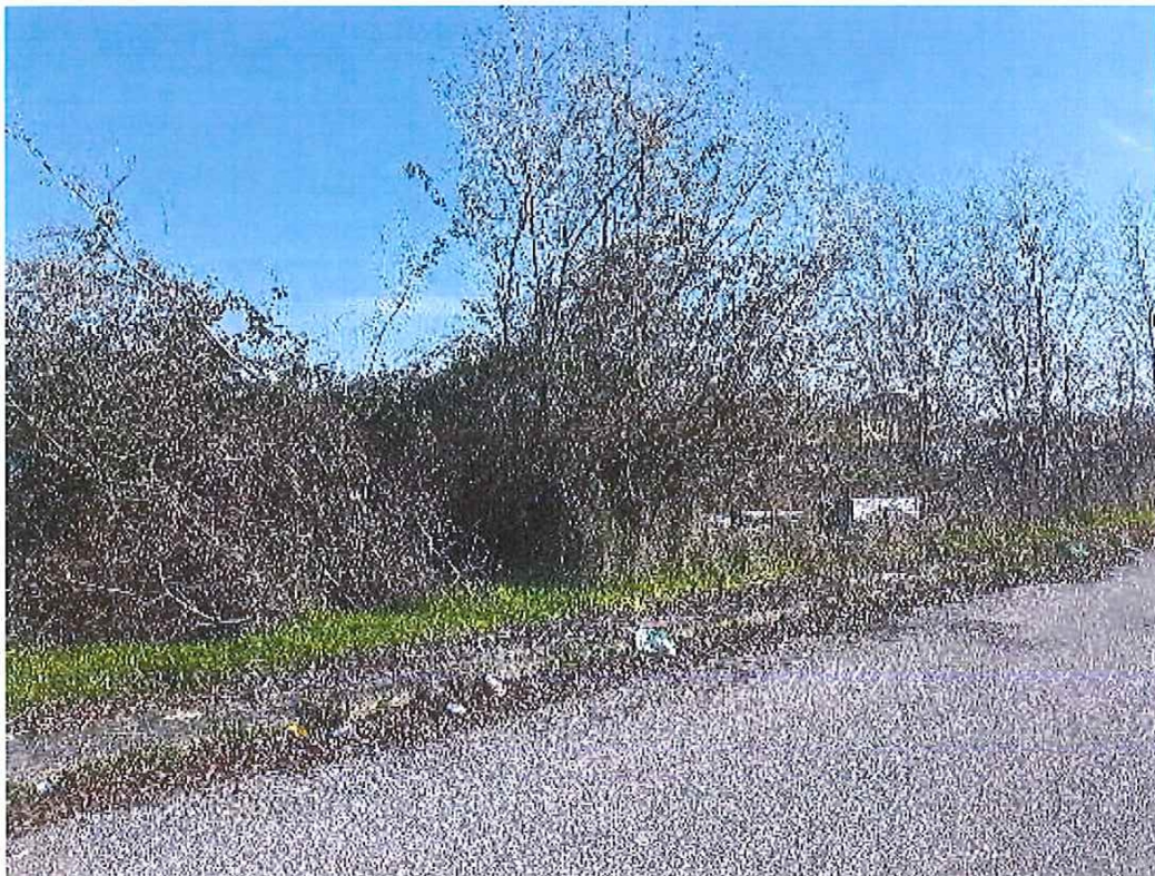
FOTO 4 - PARTICOLARE FRONTE NORD
