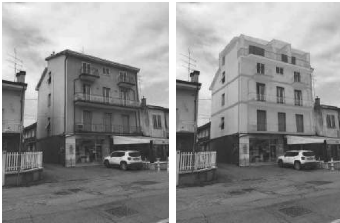
Il prospetto principale su Via Milano, 25, prima e dopo l'intervento.
