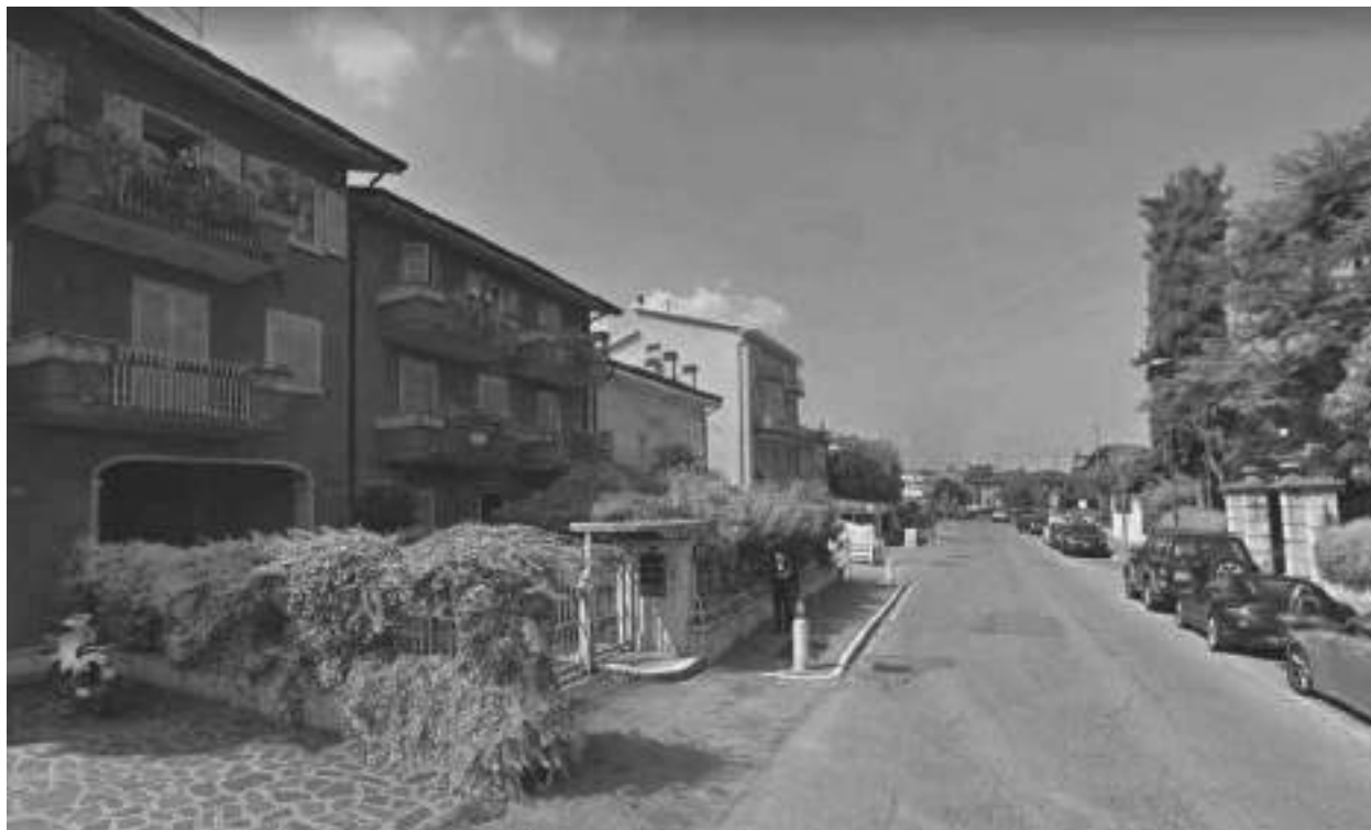
3. Il Fabbricato su Via Milano n°25, oggetto dell'intervento visto da nord/ovest
