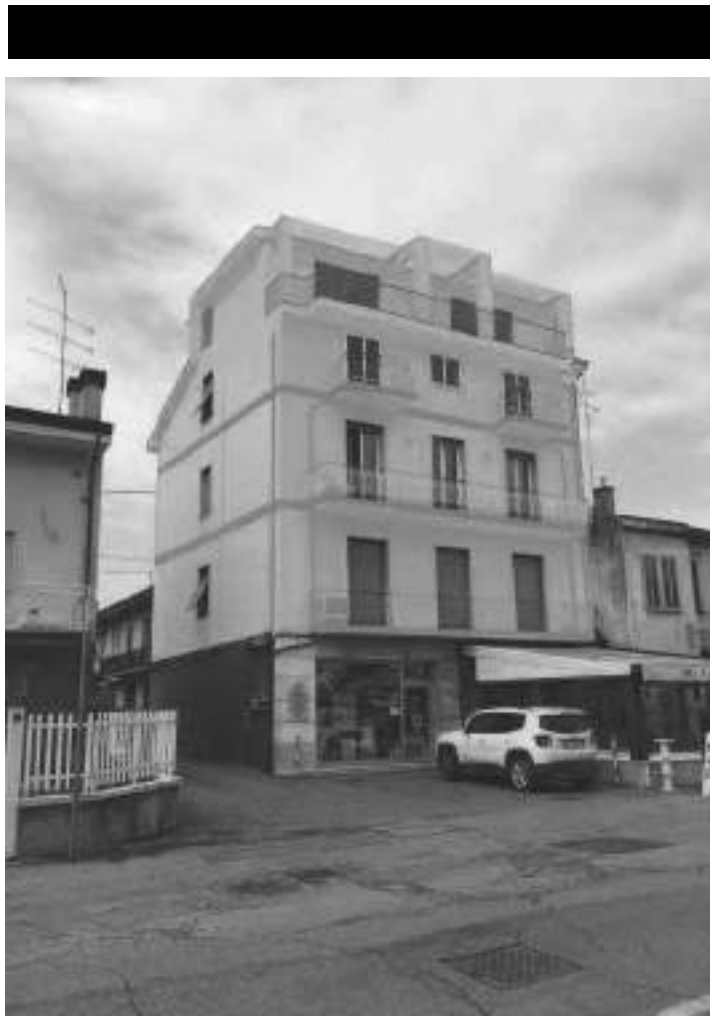
Il prospetto principale su Via Milano, 25 dopo l'intervento.
