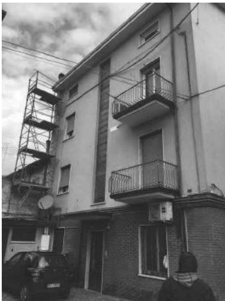
4. Il Fabbricato sul lato ovest
