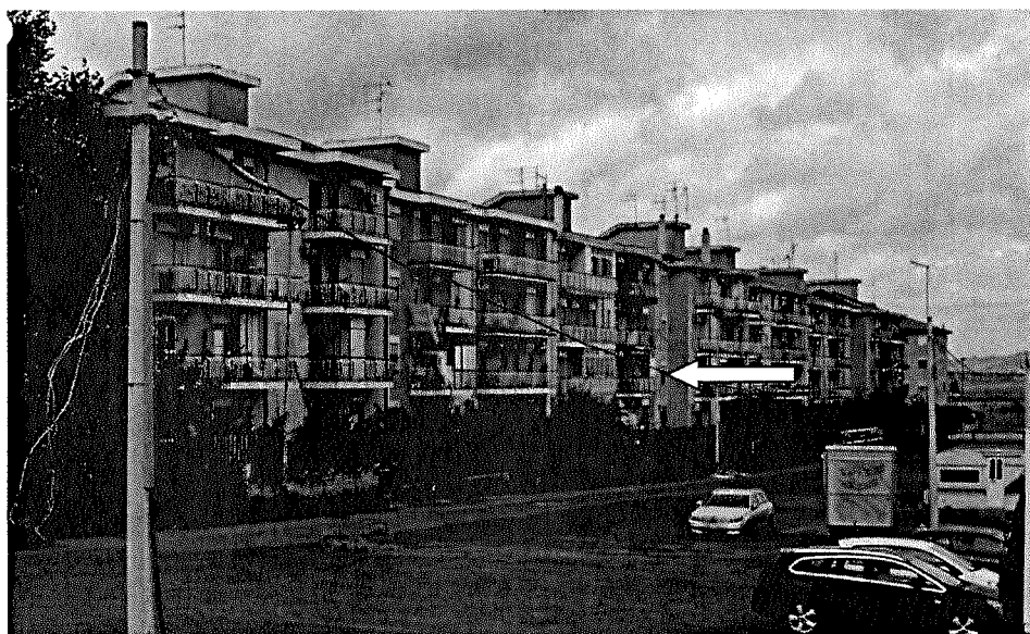
Prospetto nord del complesso condominiale con indicazione dell'appartamento pignorato - immagine tratta da Google Earth
