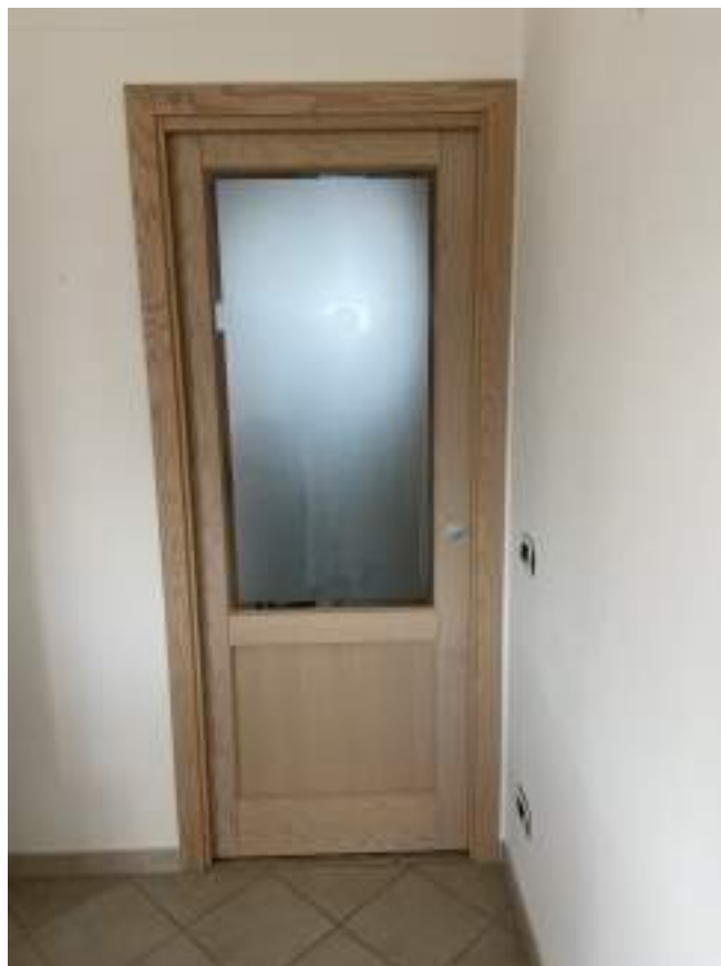
Foto 15 – Particolare infissi interni
