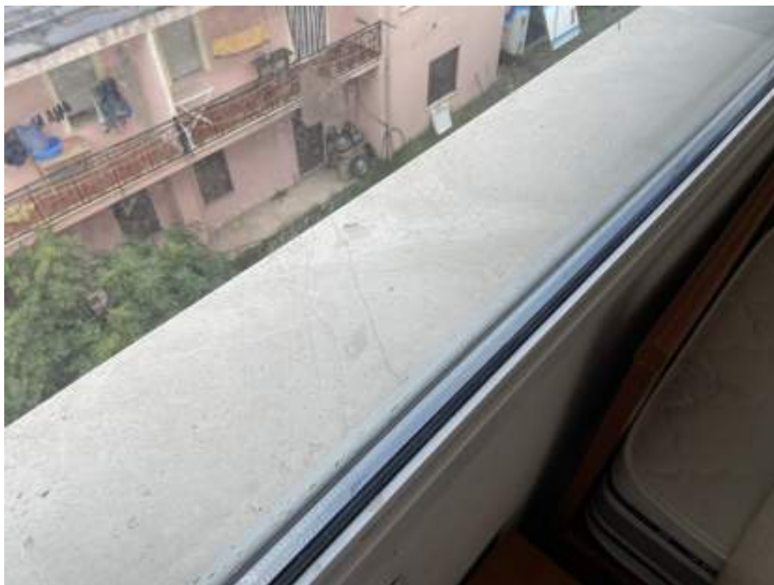
Foto 16 – Particolare infissi esterni
