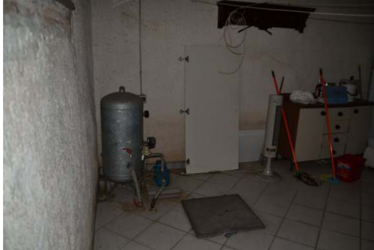
Figura 6 - scantinato - area imboccatura cisterna-riserva idrica
