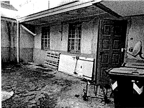
accesso al retro dal cortile comune
