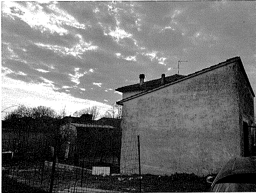
Foto 19: prospetto laterale autorimessa e i retrostanti rustici
