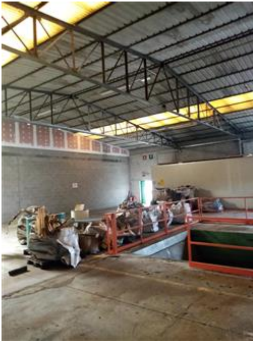
vista interna - fossa
