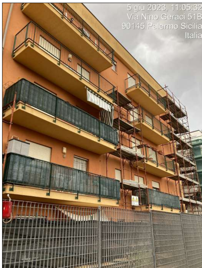
Foto n. 8 - Vista esterna Edificio Scala D
