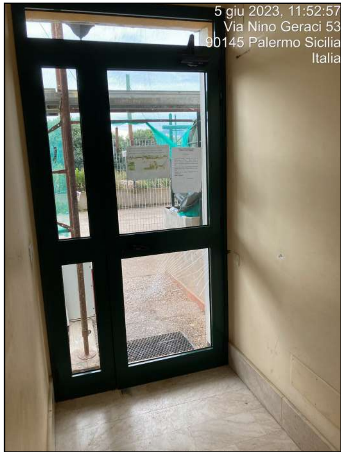
Foto n. 9 - Ingresso Edificio Scala E
