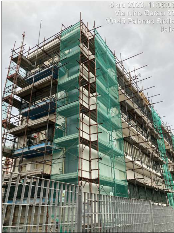
Foto n. 7 - Vista esterna Edificio Scala E
