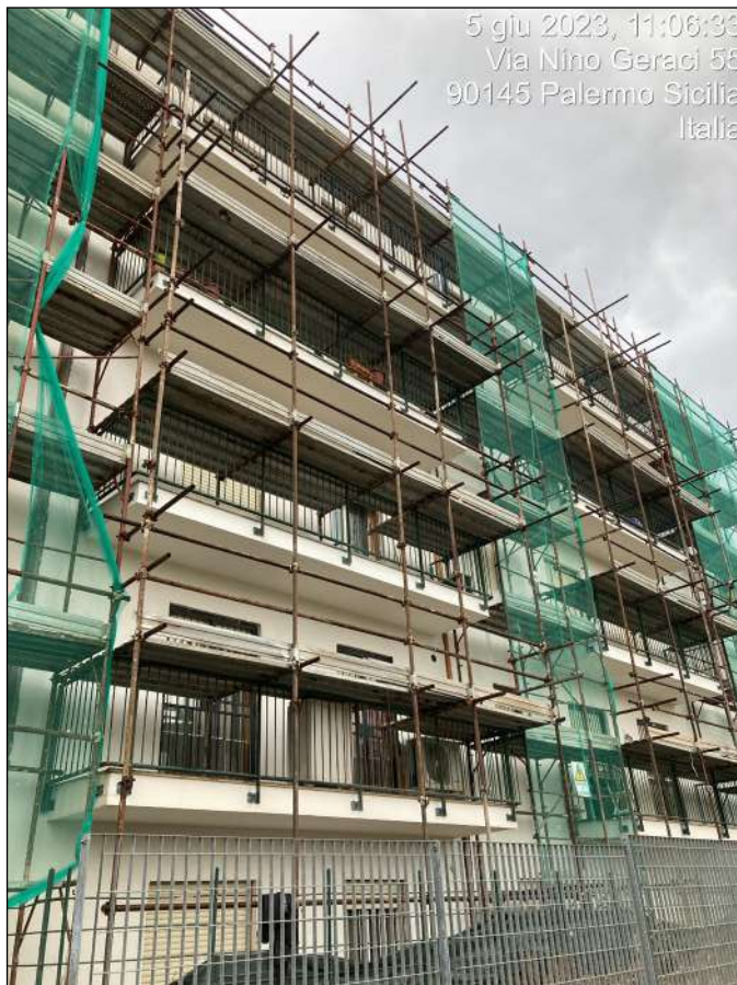
Foto n. 8 - Vista esterna Edificio Scala E
