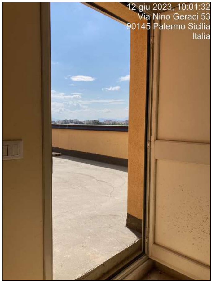
Foto n. 11 - Ingresso al terrazzo dal corpo scala condominiale
