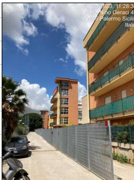
L'intero complesso immobiliare è stato edificato tra il 2009 e il 2010; i fabbricati hanno struttura portante in calcestruzzo di cemento armato antisismica, compagnoni in blocchetti di pomice o tufo, solai verosimilmente laterocementizi e copertura piana calpestabile.
