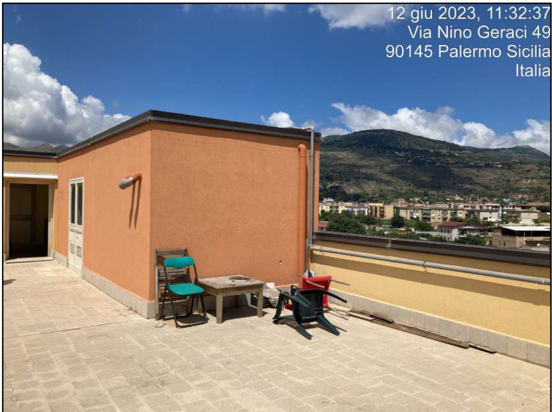
Foto n. 14 - Magazzino con terrazzo
