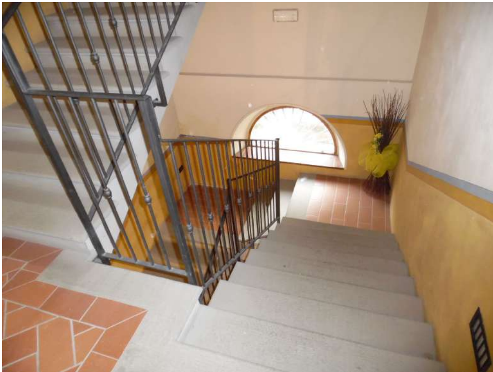
FOTO 33 – Vista vano scale (24)
