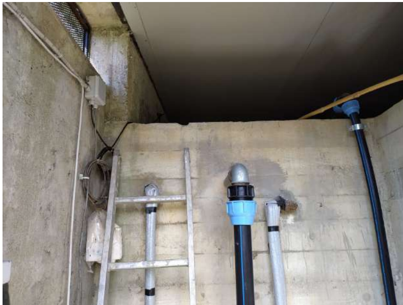
FOTO 17 – Vista interna vano tecnico cisterna
