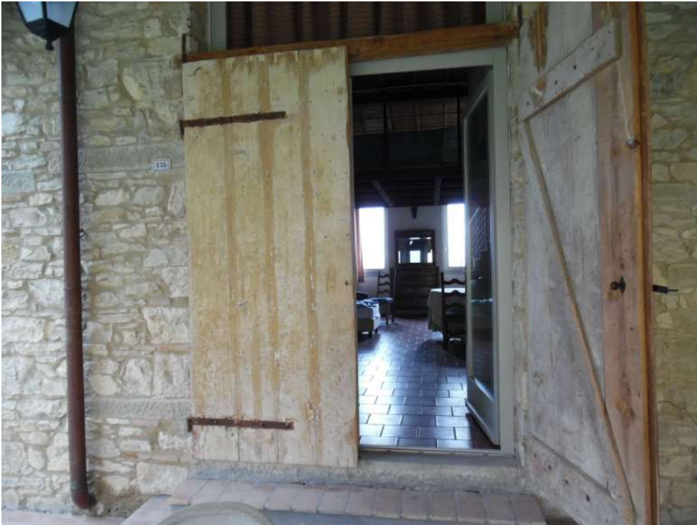
FOTO 33 – Vista ingresso camera (18)
