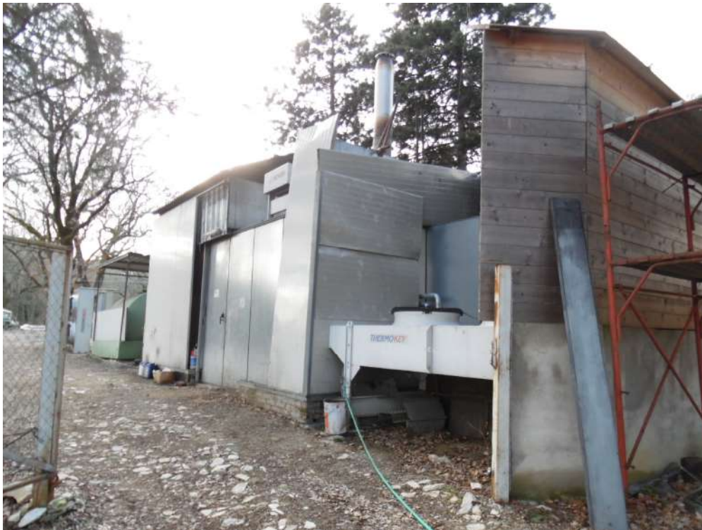
FOTO 26 – Vista esterna locale macchine
