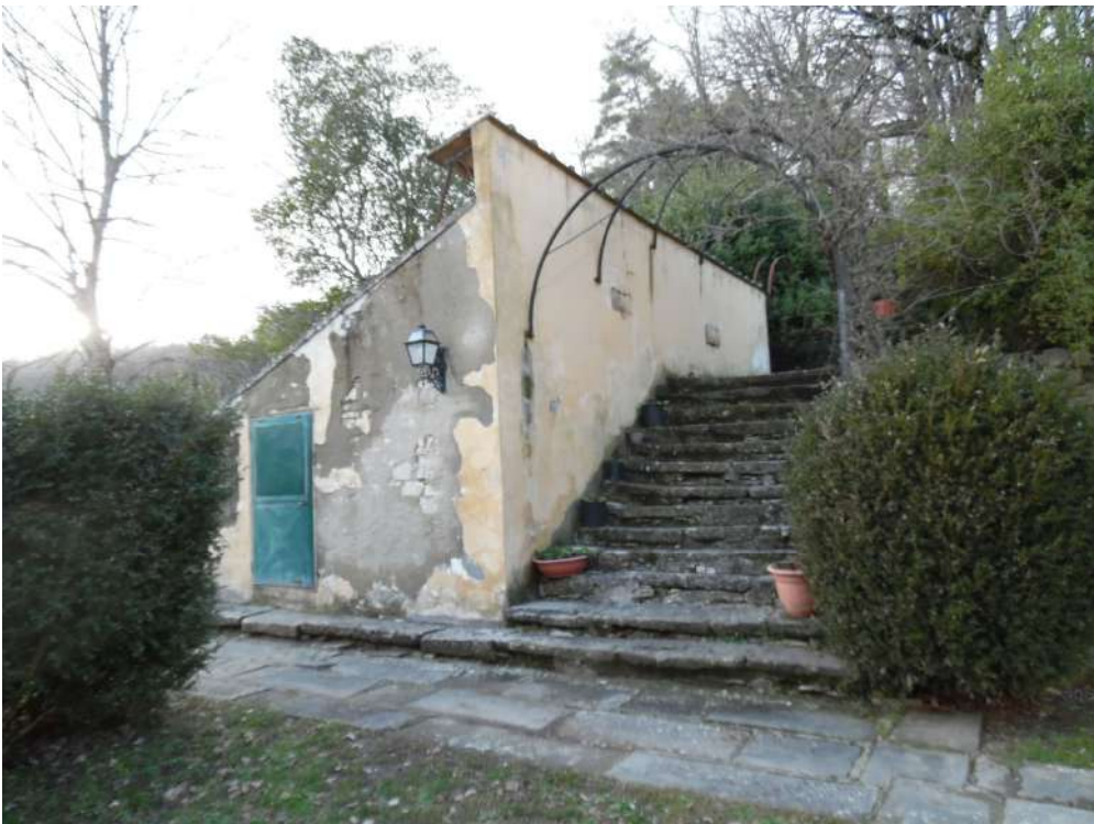
FOTO 172 – Vista esterna serra (29)
