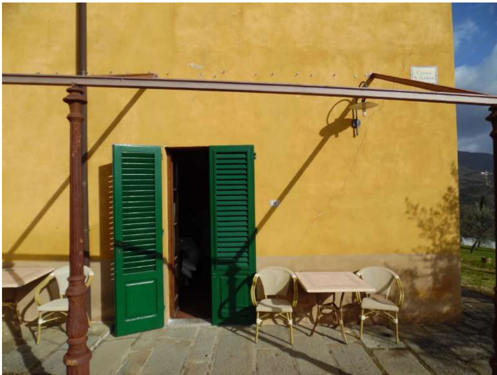
FOTO 39 – Vista ingresso camera (13)
