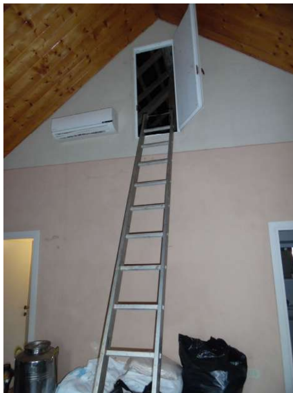
FOTO 168 – Vista accesso alla soffitta (80)
