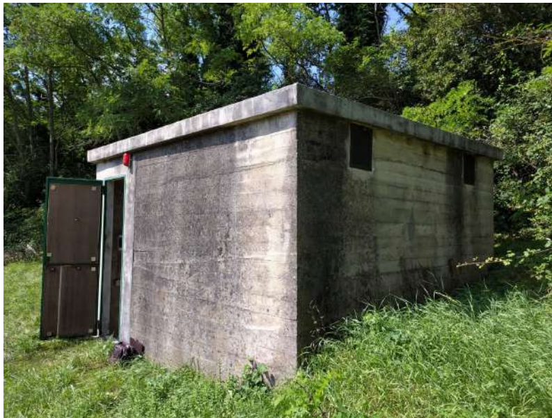
FOTO 15 – Vista esterna vano tecnico cisterna
