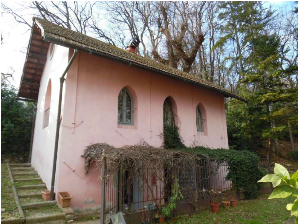
FOTO 148 – Vista esterna annesso
