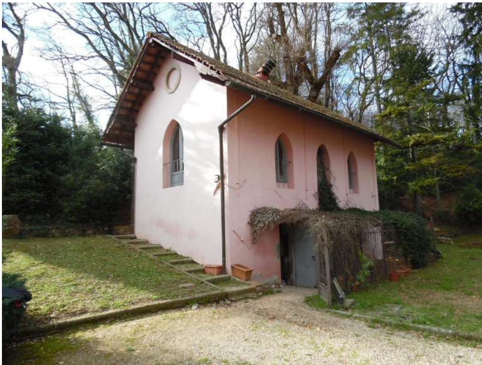
FOTO 152 – Vista esterna annesso
