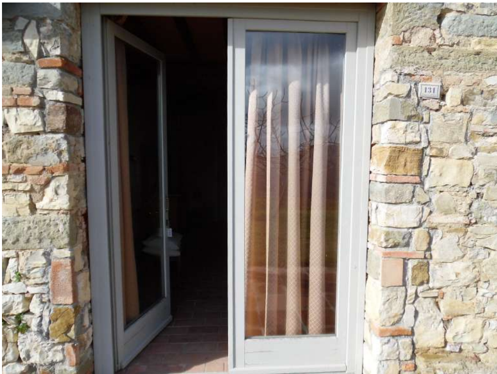
FOTO 50 – Vista ingresso camera (3)
