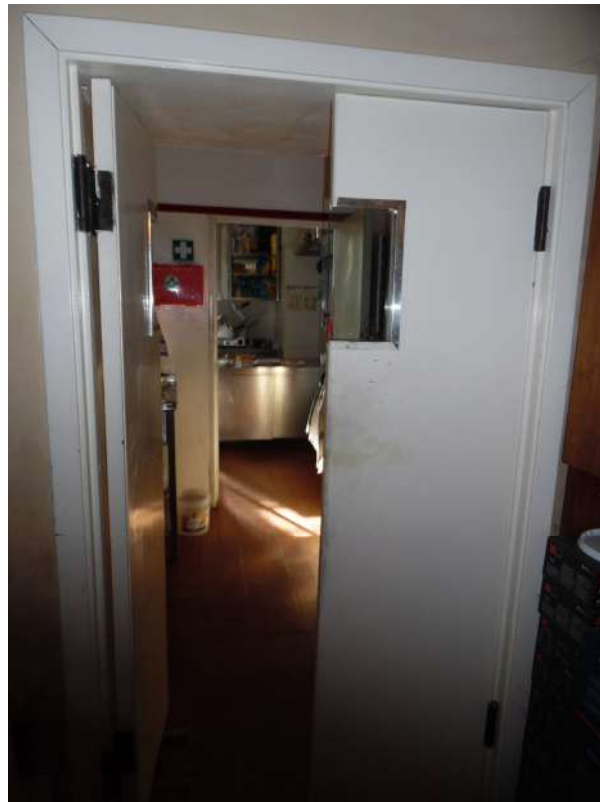
FOTO 49 – Vista Ingresso cucina (25)
