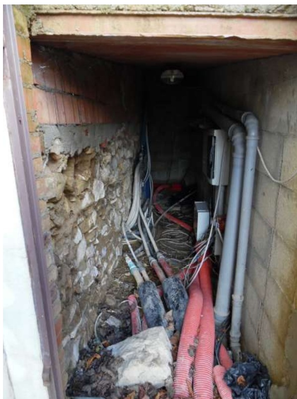
FOTO 9 – Vista vano tecnico
