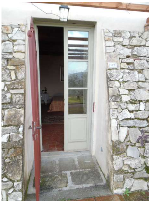
FOTO 15 – Vista ingresso camera (4)
