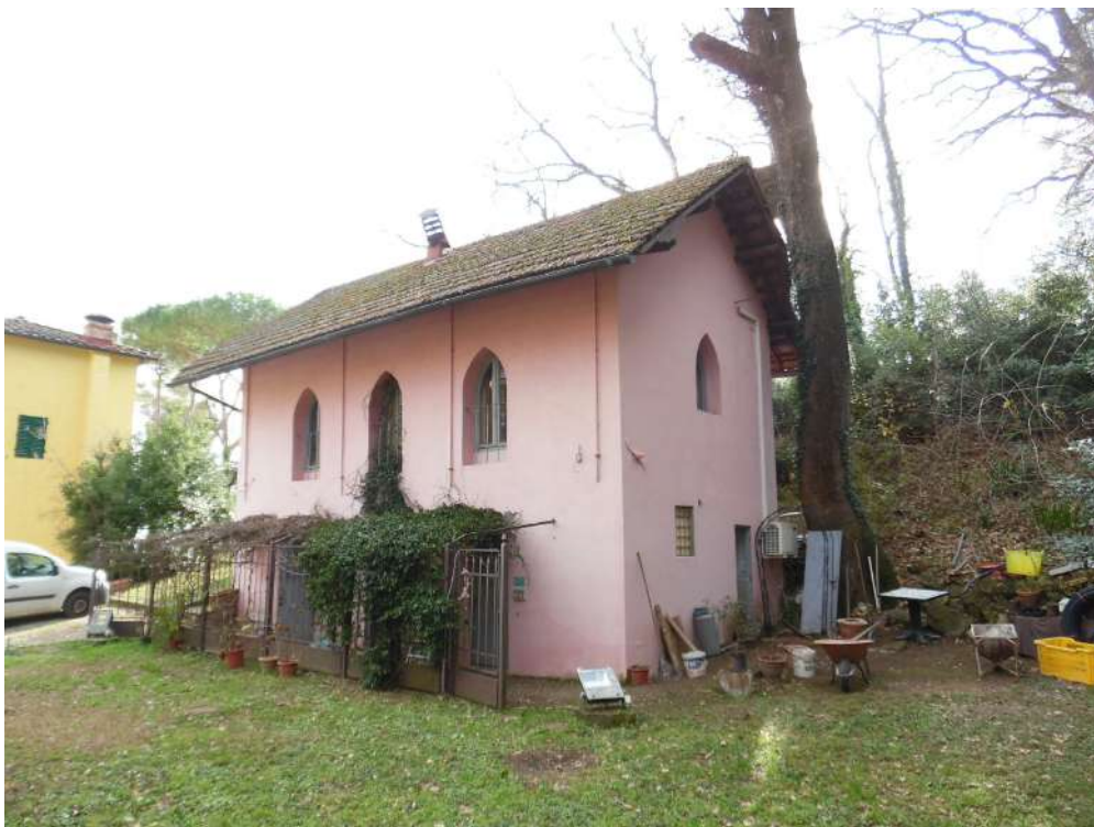
FOTO 150 – Vista esterna annesso
