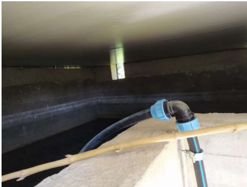
FOTO 18 – Vista interna vano tecnico cisterna
