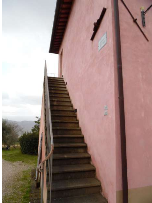
FOTO 32 – Vista scala di accesso piano primo
