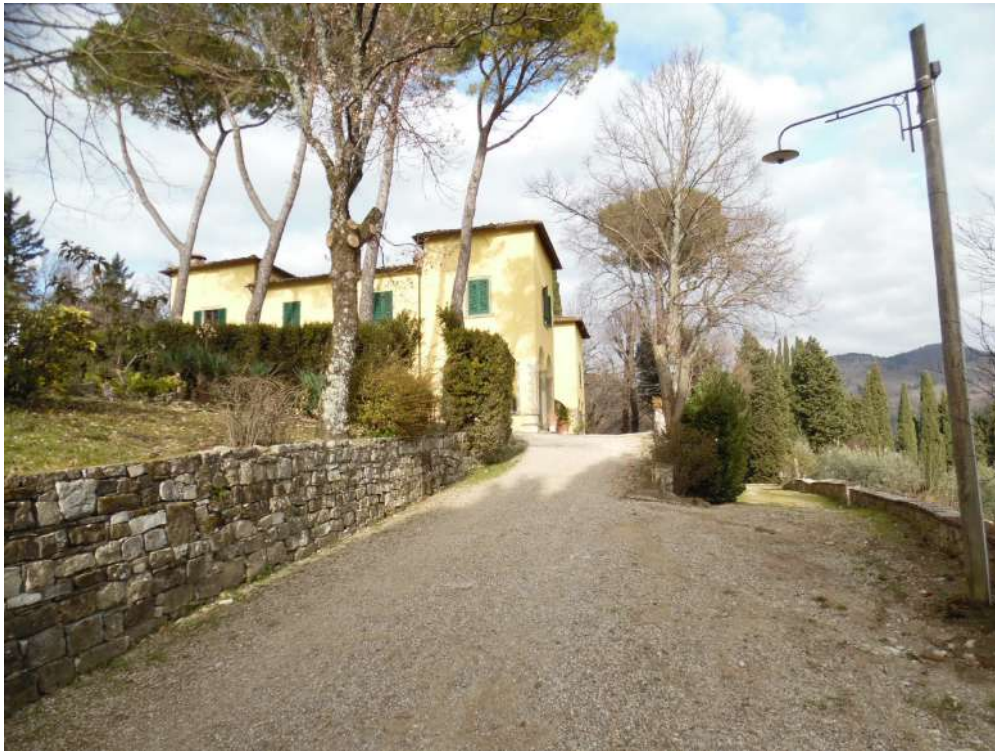
FOTO 7 – Vista strada di accesso
