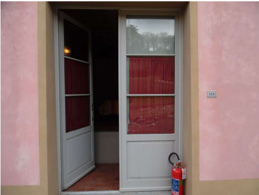
FOTO 27 – Vista ingresso camera (7)
