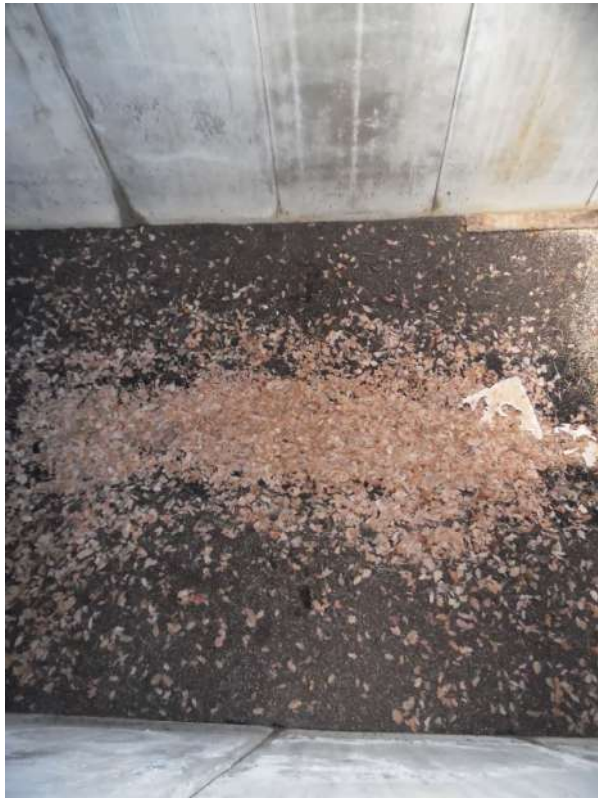
FOTO 15 – Vista silo orizzontale (1)
