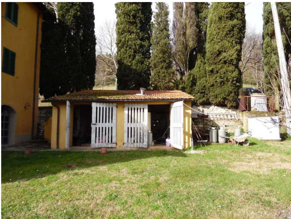
FOTO 38 – Vista rimessa/locale tecnico (15-16)
