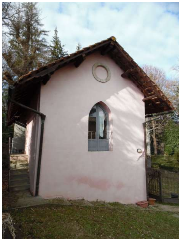
FOTO 149 – Vista esterna annesso
