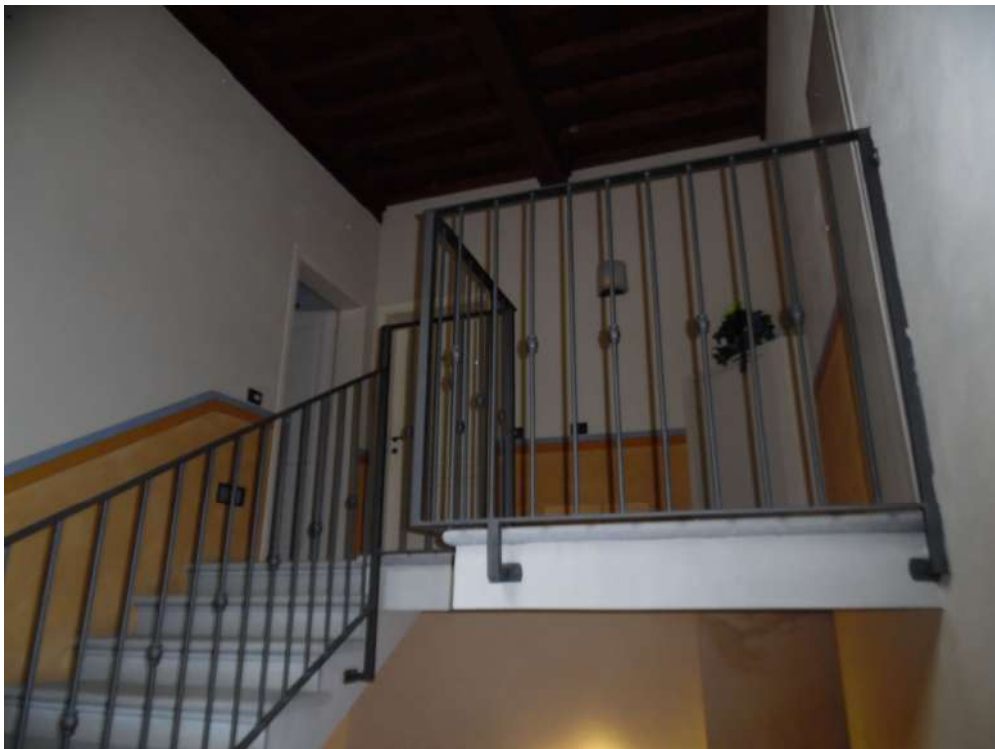
FOTO 8 – Vista vano scale (37)
