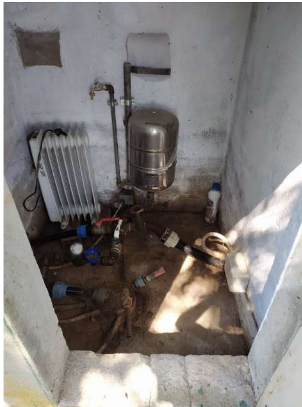
FOTO 21 – Vista interna pozzo
