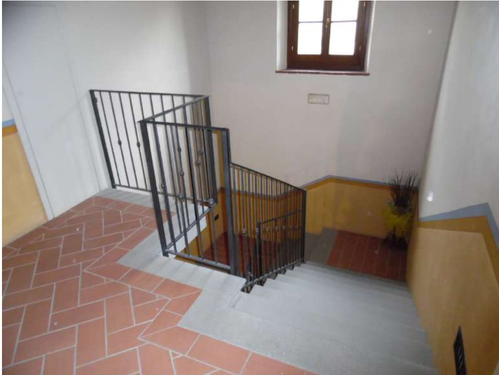
FOTO 7 – Vista vano scale (37)
