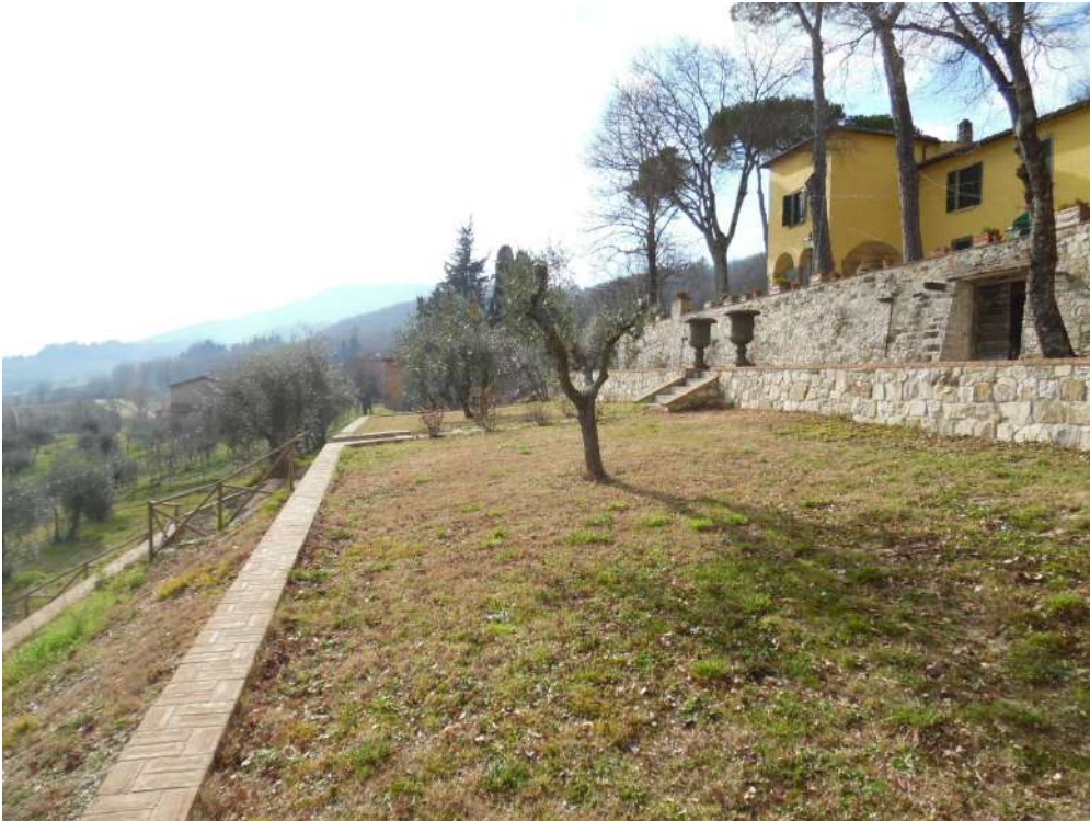
FOTO 15 – Vista terreni antistanti la villa
