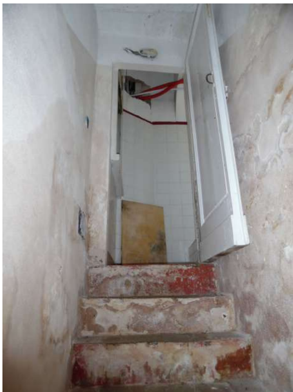
FOTO 60 – Vista scala di accesso cantina (1)
