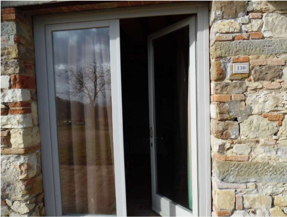
FOTO 52 – Vista ingresso camera (1)
