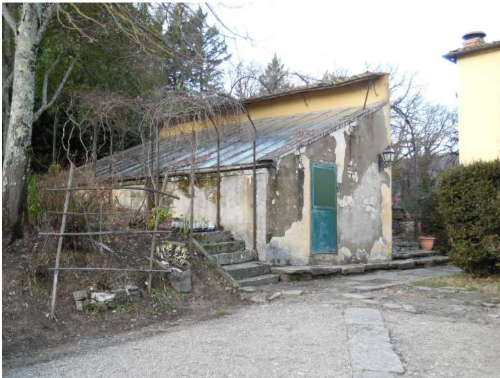
FOTO 173 – Vista esterna serra (29)
