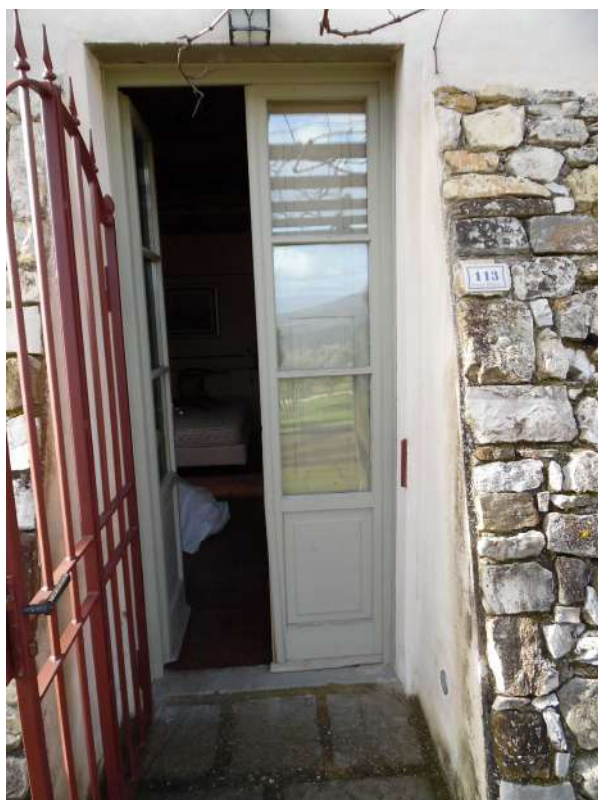
FOTO 19 – Vista ingresso camera (7)
