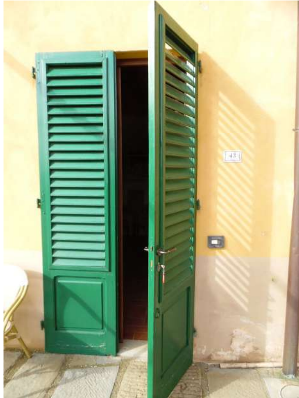
FOTO 51 – Vista ingresso camera (4)
