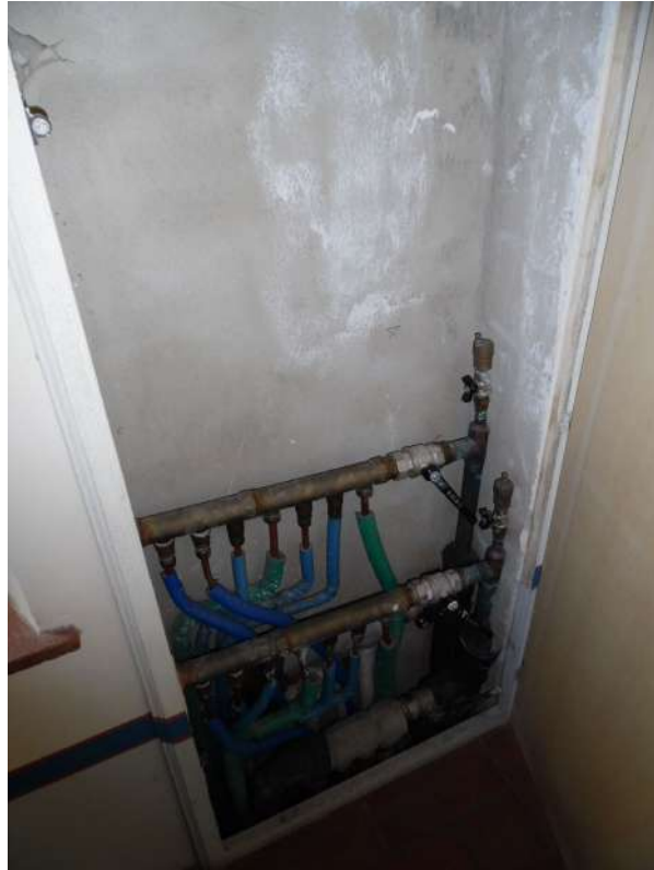
FOTO 38 – Vista vano impianti
