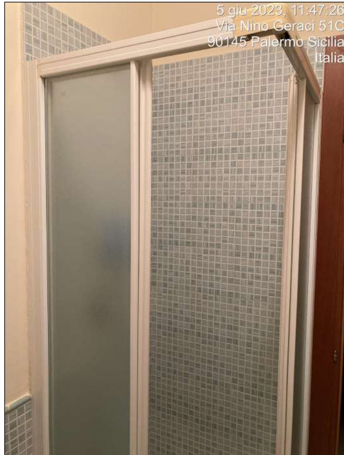
Foto n. 23 - Interni: w.c. doccia
