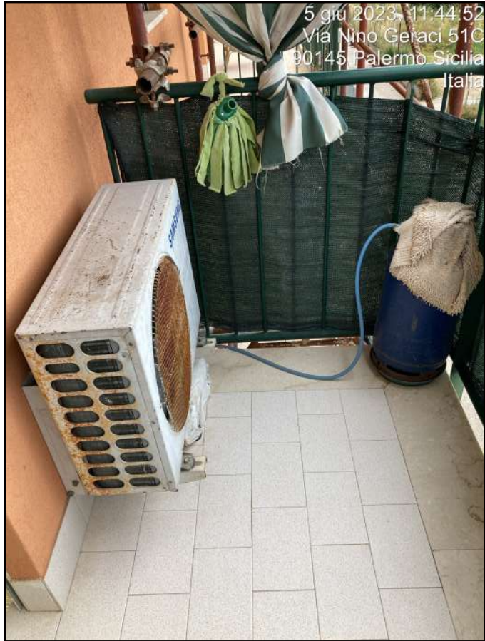
Foto n. 27 - Interni: balcone della cucina
