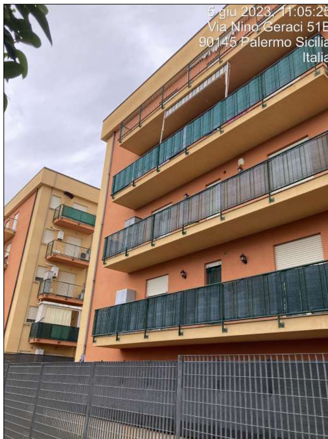
Foto n. 7 - Vista esterna Edificio Scala D
