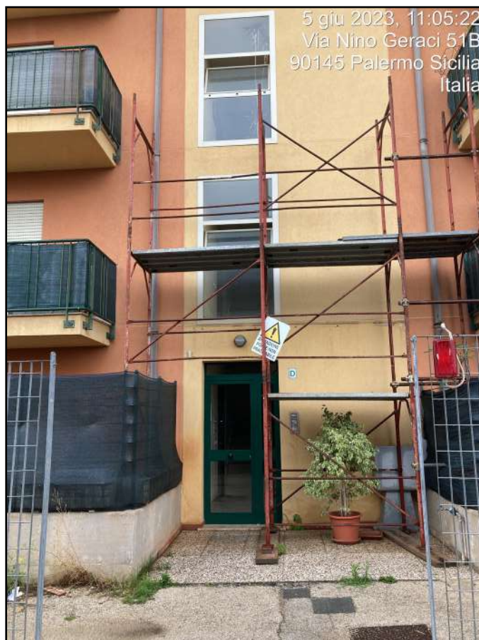
Foto n. 9 - Vista esterna Edificio Scala D
