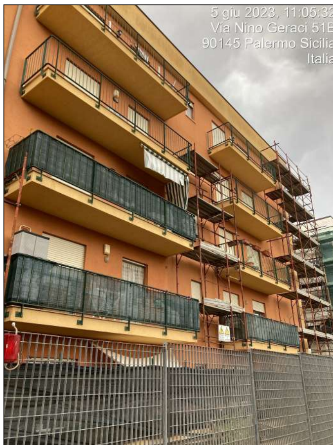
Foto n. 8 - Vista esterna Edificio Scala D
