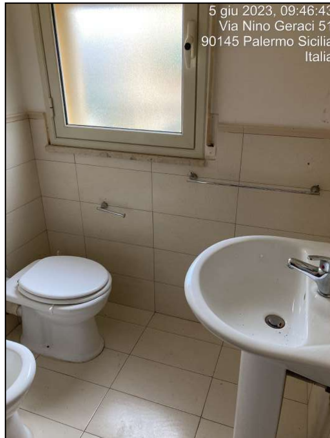
Foto n. 18 - Interni: w.c. con doccia
