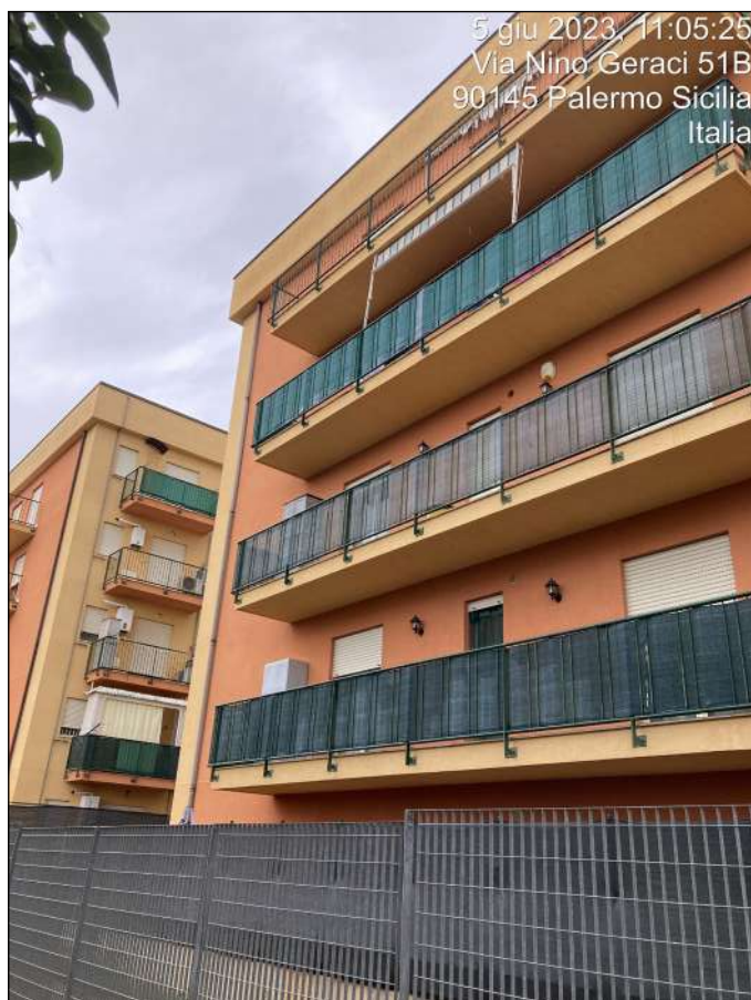
Foto n. 7 - Vista esterna Edificio Scala D
