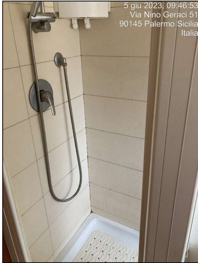
Foto n. 19 - Interni: Interni: w.c. con doccia
