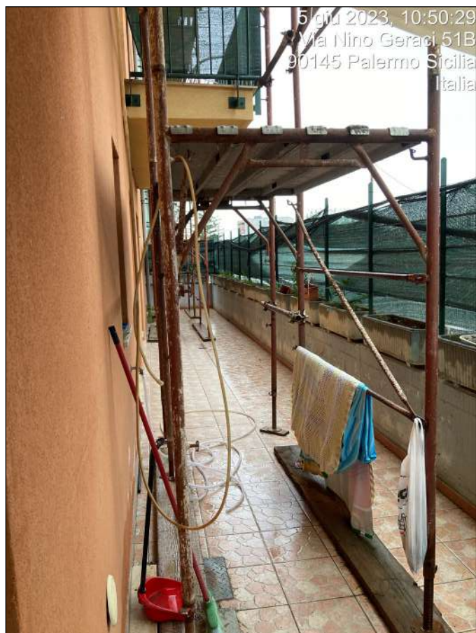
Foto n. 25 - Esterni: corte di pertinenza
