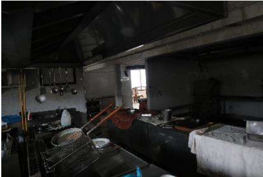
VISTA INTERNA DELLE CUCINE (RISTORANTE)
