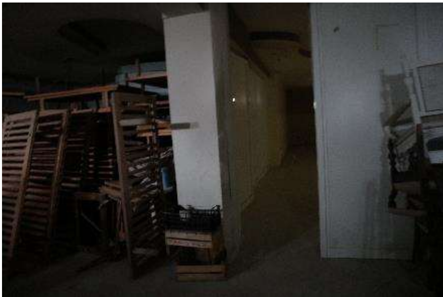
VISTA INTERNA DEL PIANO SEMINTERRATO (ALBERGO)
