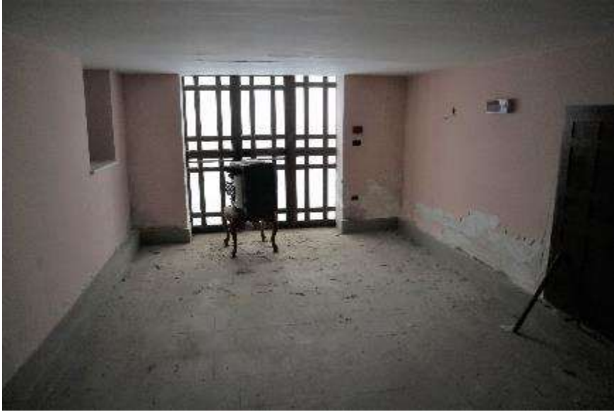
VISTA INTERNA DEL PIANO SEMINTERRATO (ALBERGO)
