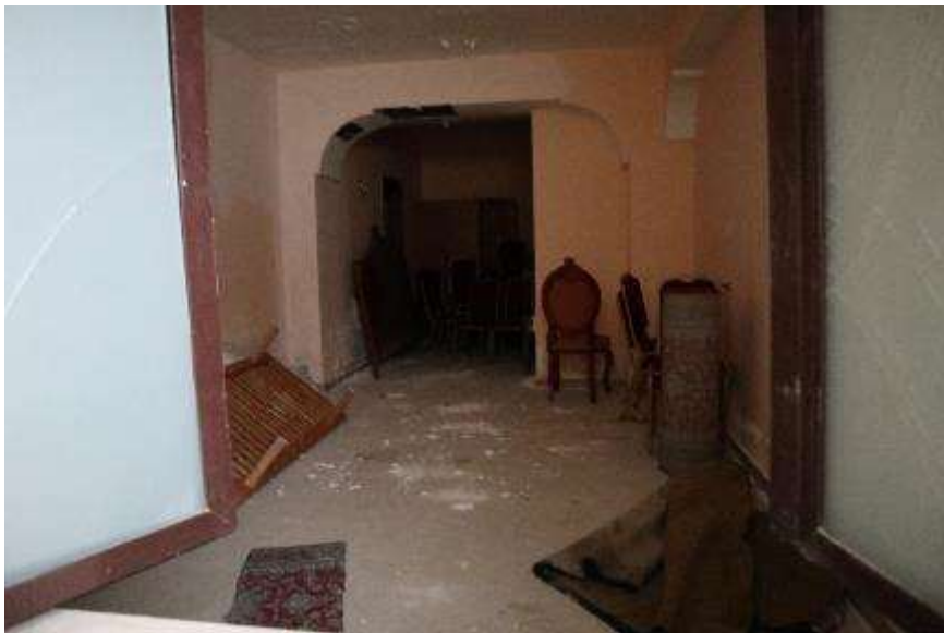
VISTA INTERNA DEL PIANO SEMINTERRATO (ALBERGO)
