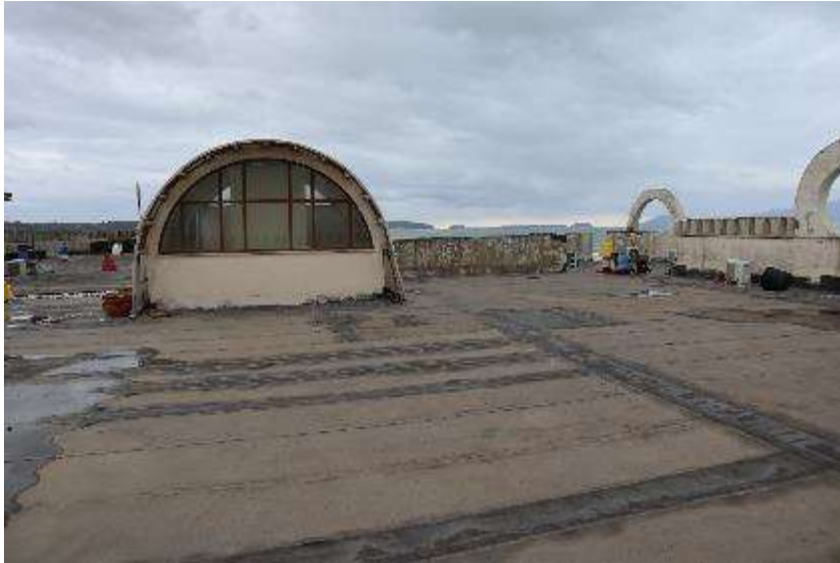
VISTA ESTERNA DEL LASTRICO SOLARE AL PIANO SECONDO (ALBERGO)
