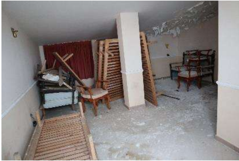
VISTA INTERNA DEI LOCALI DI SGOMBERO AL PIANO SECONDO (ALBERGO)
