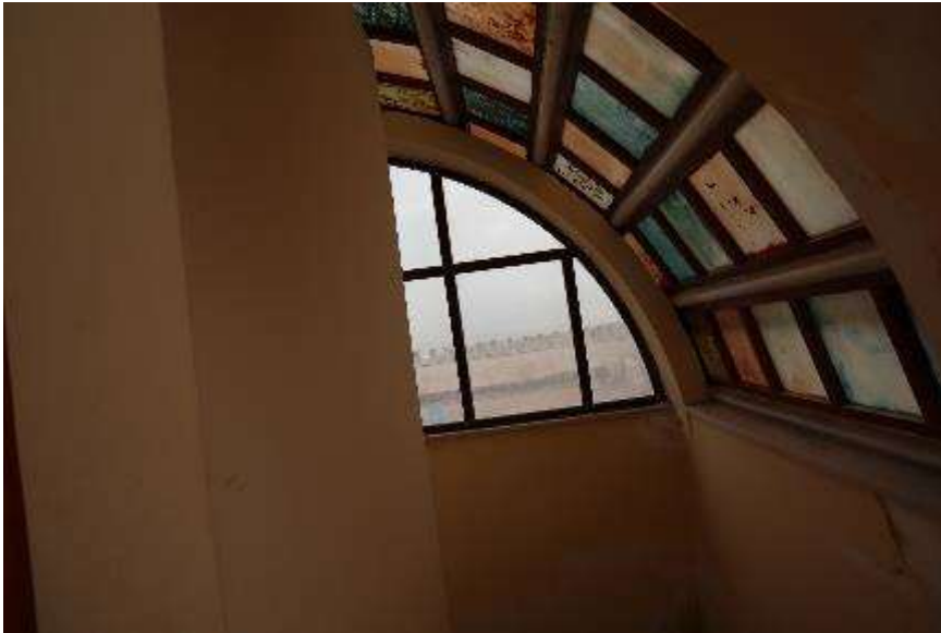
VISTA INTERNA DEL VANO SCALA (ALBERGO)
