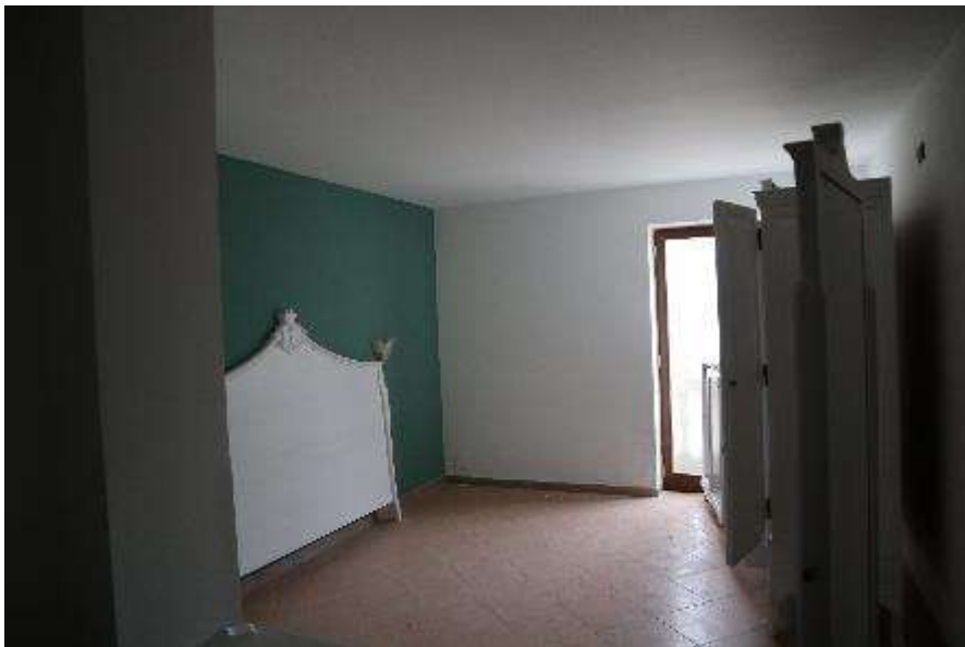
VISTA INTERNA DI UNA CAMERA AL PIANO TERRA (ALBERGO)
