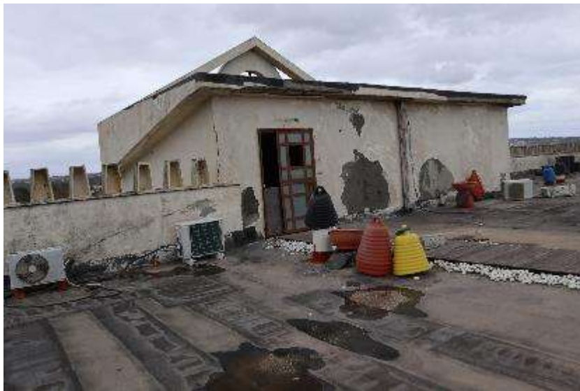
VISTA ESTERNA DEI LOCALI DI SGOMBERO AL PIANO SECONDO (ALBERGO)
