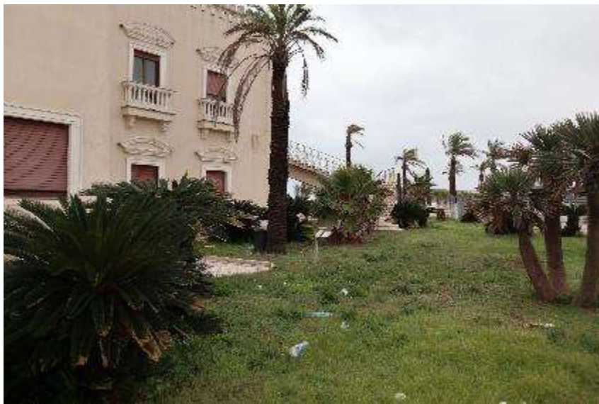
VISTA DELL'AREA ESTERNA
