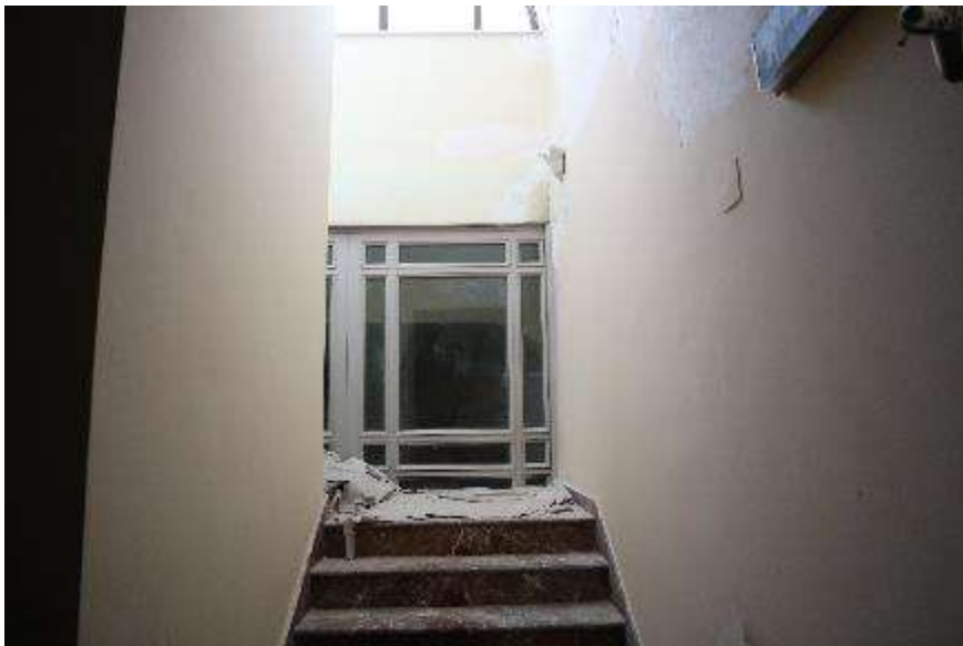
VISTA INTERNA DEL VANO SCALA (ALBERGO)
