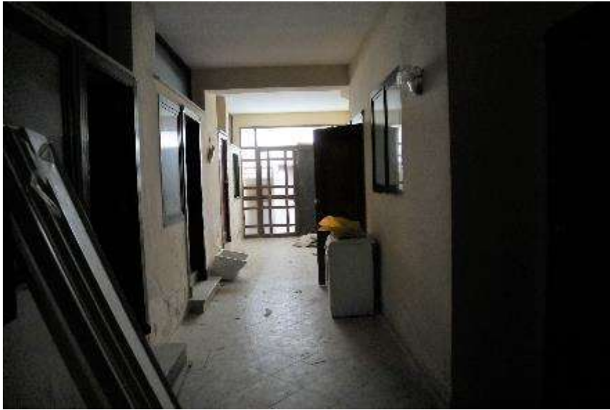
VISTA INTERNA DEL PIANO SEMINTERRATO (ALBERGO)
