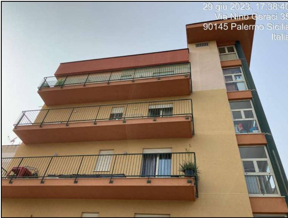
Foto n. 7 - Vista esterna Edificio Scala B
