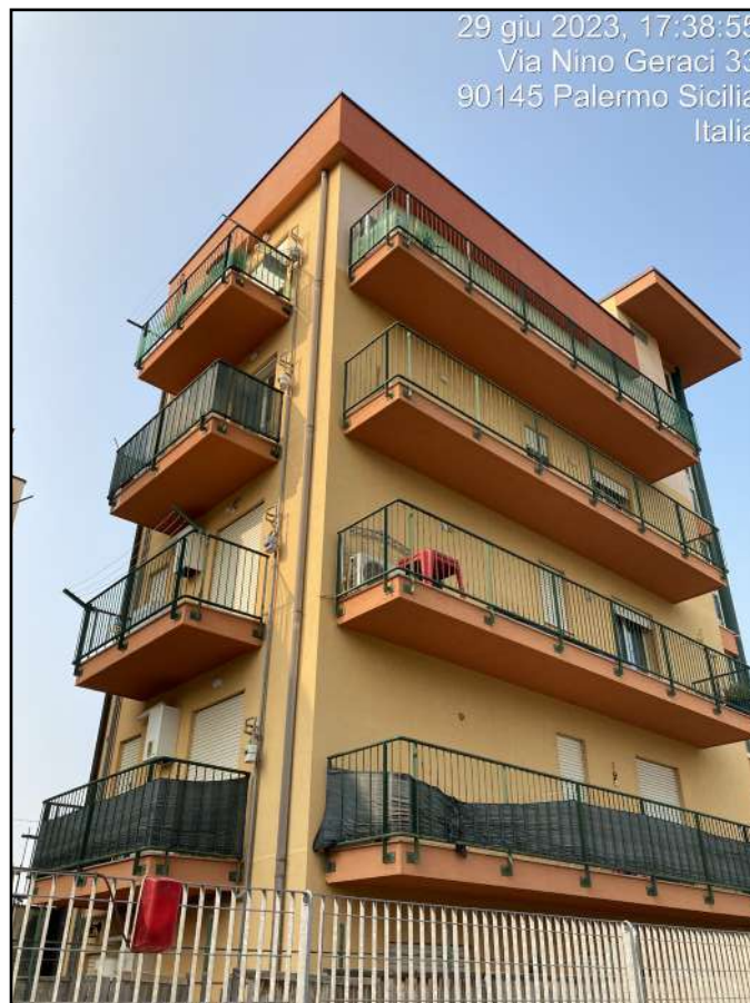
Foto n. 8 - Vista esterna Edificio Scala B
