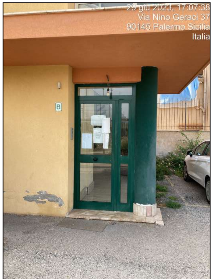
Foto n. 10 - Vista esterna Edificio Scala B
