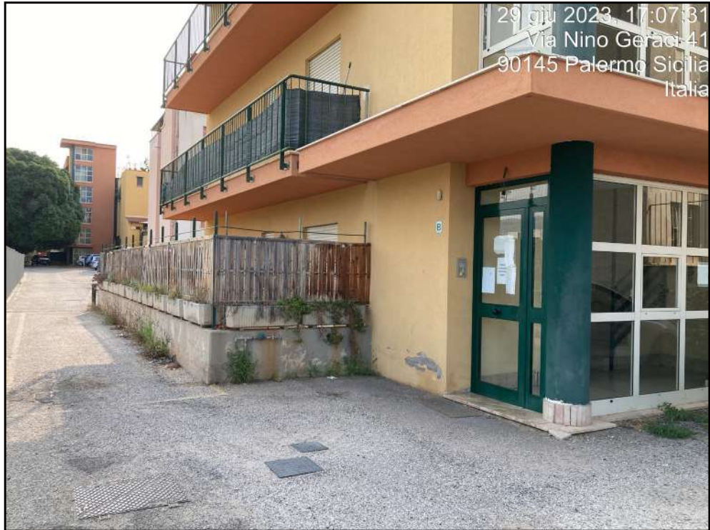
Foto n. 9 - Vista esterna Edificio Scala B
