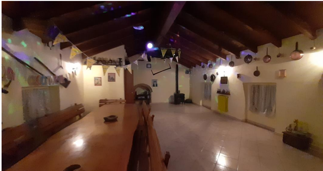
P2 - sottotetto ristrutturato E' visibile sul lato sinistro del fondo il piccolo volume in cui è stato realizzato un bagno
