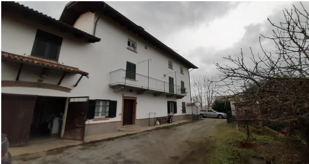
Vista principale del fabbricato
