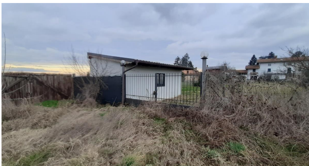
Recinzione sul fondo della particella 373 e vista del fabbricato abusivo
