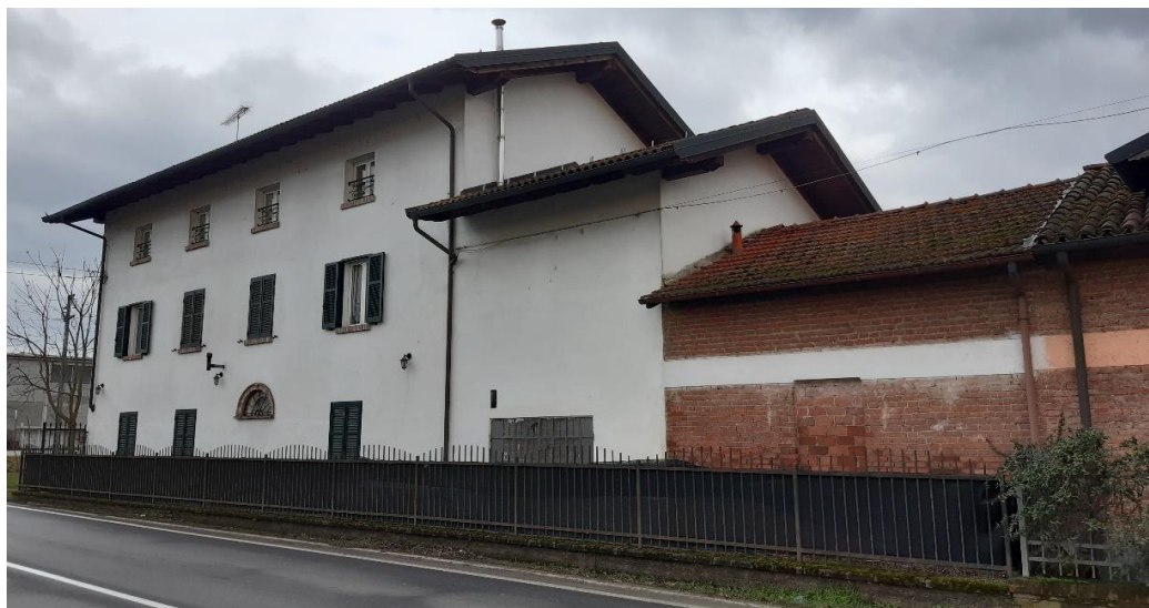
Vista generale dalla provinciale 155
