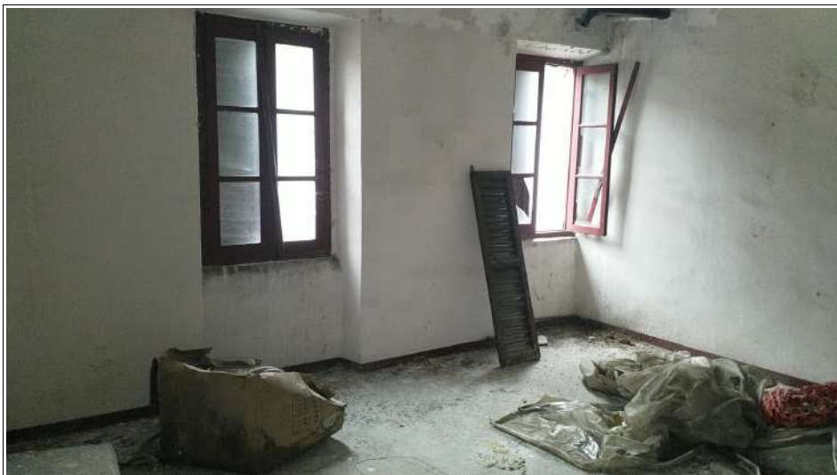
Foto di uno dei locali del piano primo
