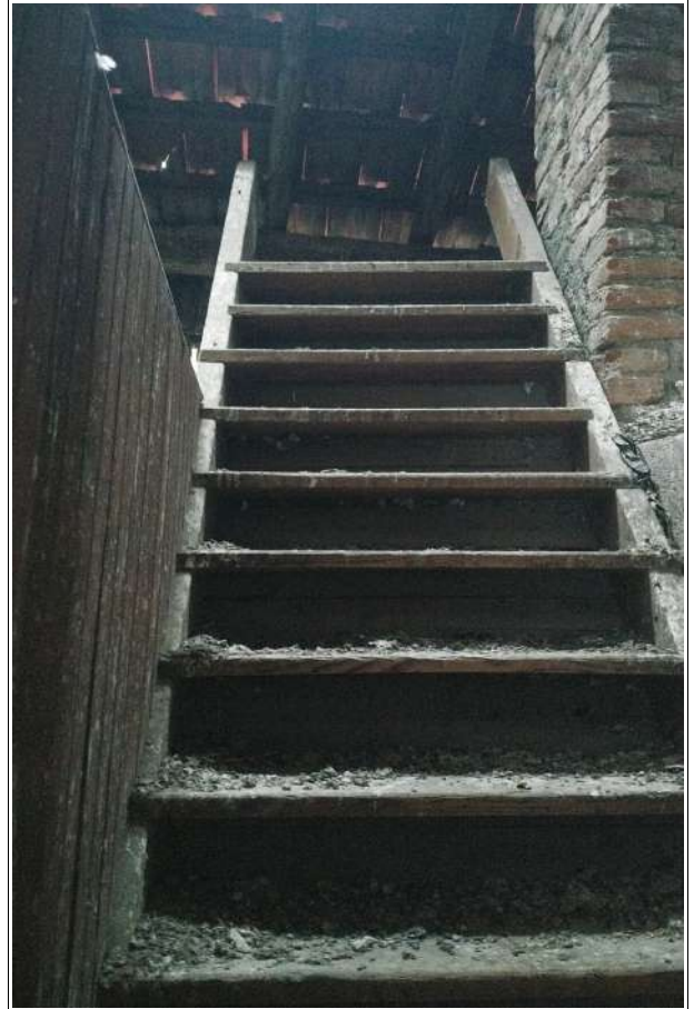
Foto della scala che conduce al sottotetto, posta nel locale wc
