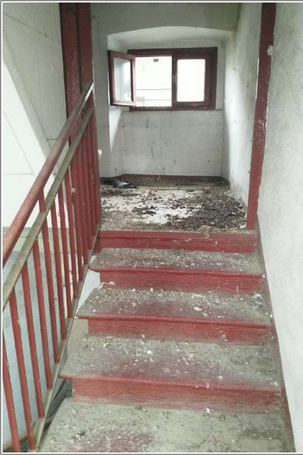
Ripresa della scala che accede al locale wc posto al piano mezzanino
