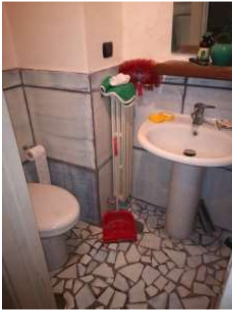
Foto 24- wc all'interno del locale box/garage p.t. sub 14
