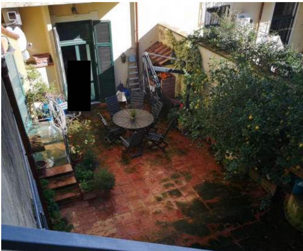
Foto 21- balcone su altra proprietà sub 17 - non autorizzato
