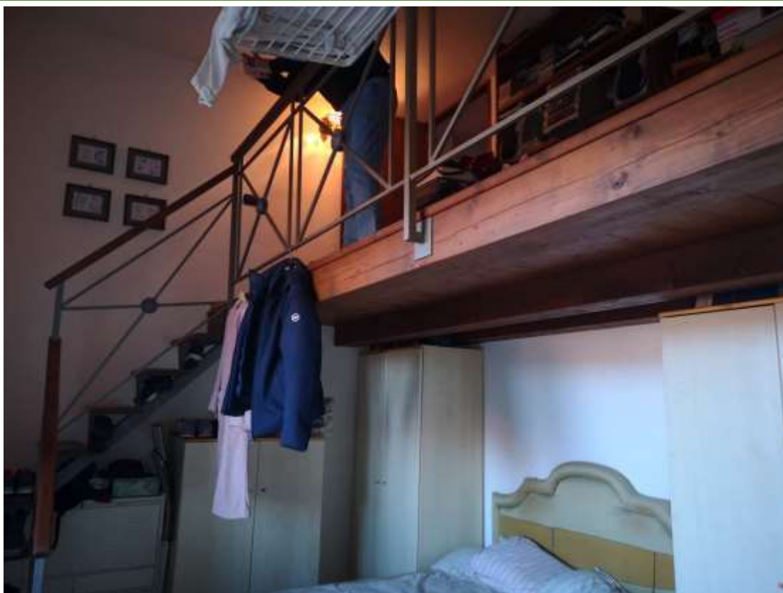
Foto 17 – letto 2 appartamento piano 1° sub 17 – soppalco non autorizzato
