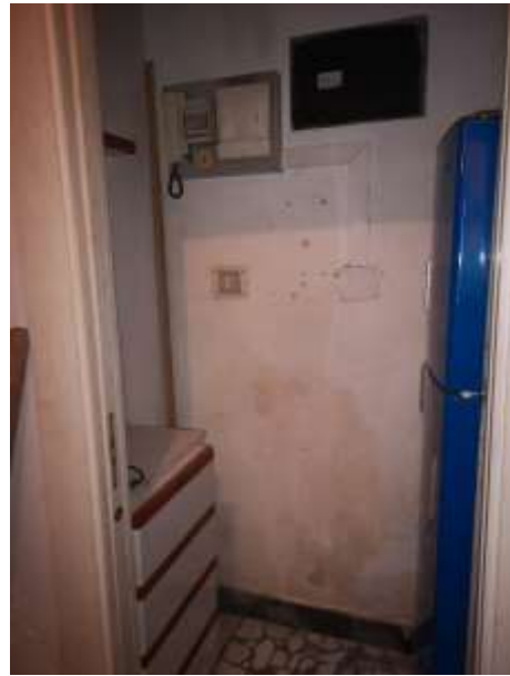
Foto 25- deposito all'interno del locale box/garage p.t. sub 14
