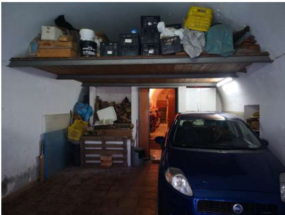
Foto 23- locale box/garage p.t. sub 14 - Via Avallone 14 - soppalco non autorizzato
