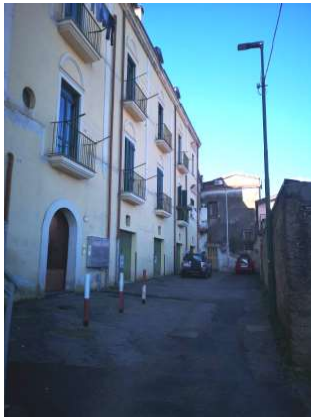
Foto 2 – Via Casa Avallone
