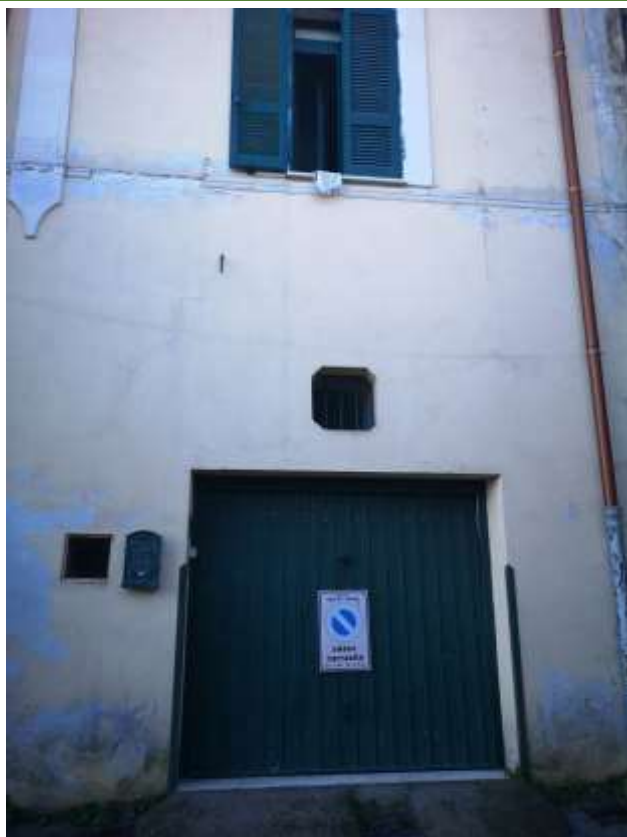
Foto 22- locale box/garage p.t. sub 14 - Via Avallone 14 - ingresso al sub 17
