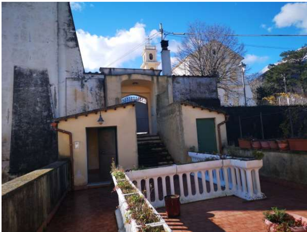
Foto 18 - locale deposito piano 2° sub 17 - accesso su Piazzetta del Tiglio
