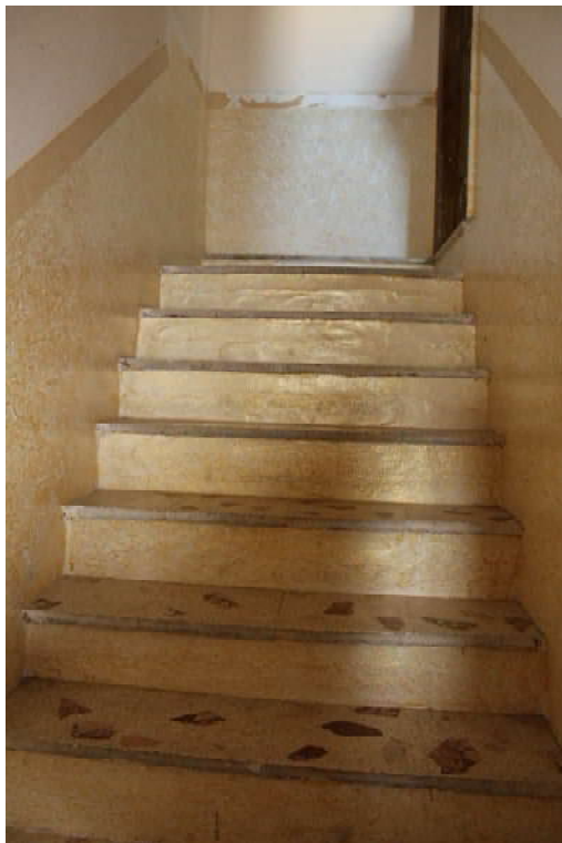
Foto n. 21 – Vano scala, quinta e ultima rampa.
