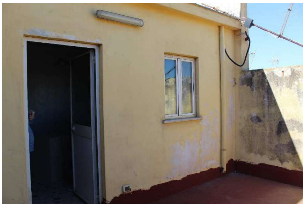
Foto n. 26 – Prospetto rientrato su Via Aguglia. (piano terzo).
