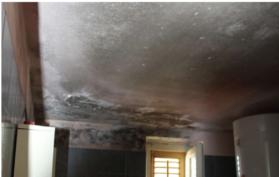
Foto n. 33 – W.c. al piano terzo: intradosso solaio di copertura.
