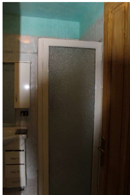
Foto n. 20 – w.c. (Vano 6, piano secondo).
