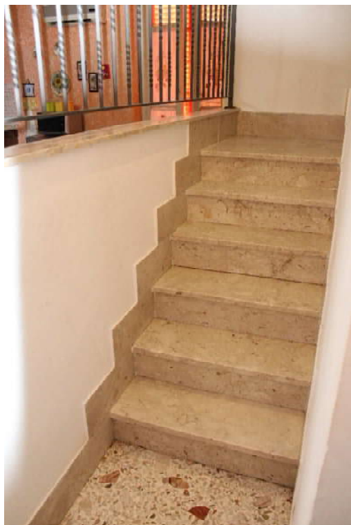
Foto n. 12 – Vano scala, seconda rampa.
