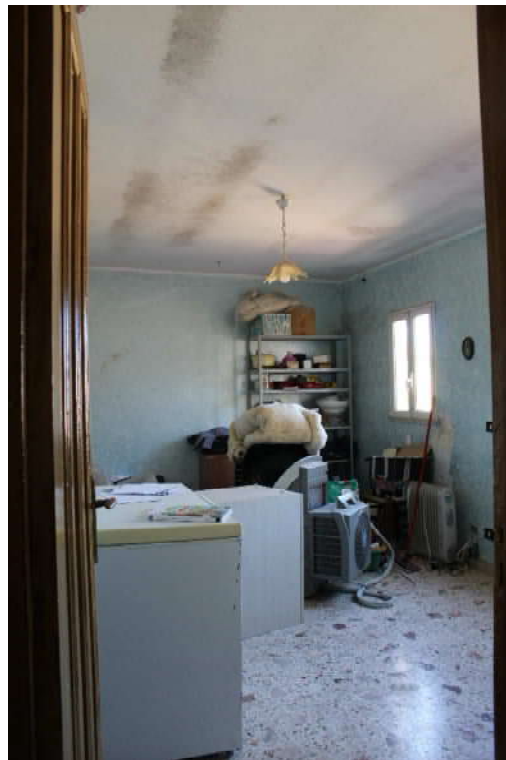
Foto n. 22 – Camera (Vano 8, piano terzo).
