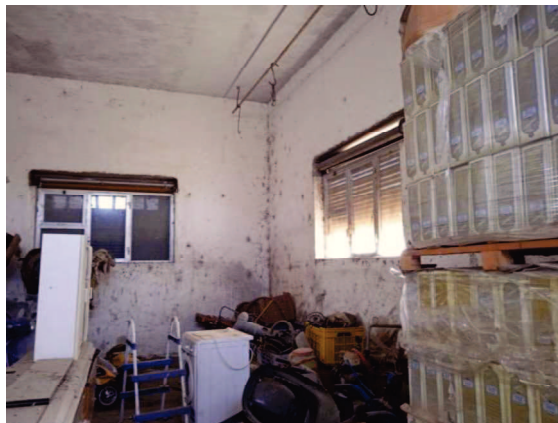
Part. 405 sub 3 - Vista interna deposito
