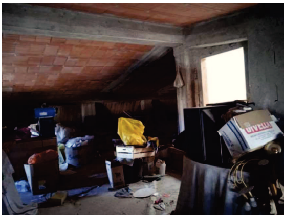
Part. 405 sub 11 - Vista interna piano secondo
