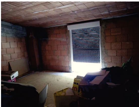
Part. 405 sub 10 - Vista interna piano secondo
