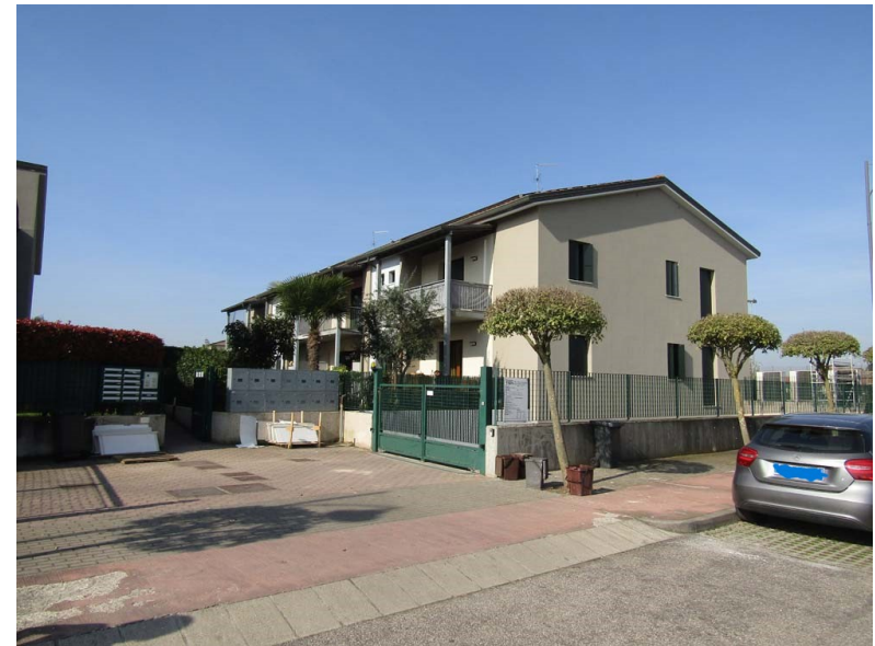
Foto 2: vista dell'accesso carroia e pedonale principali al condominio
