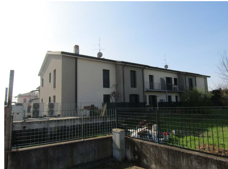
Foto 4: vista da nord
