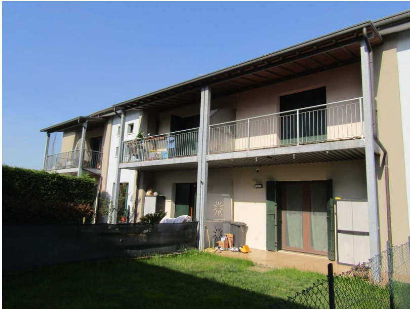
Foto 7: vista del prospetto interno sud-est
