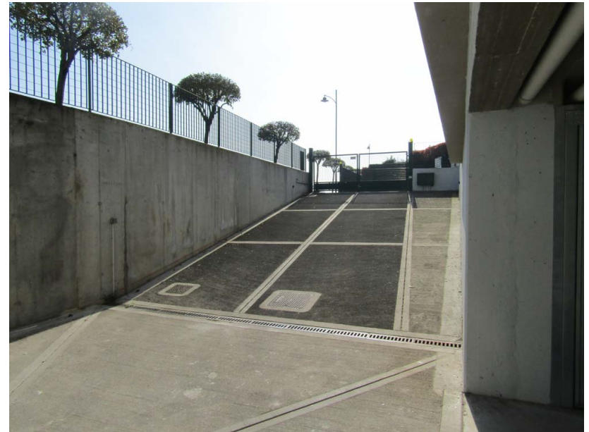
Foto 24: vista della rampa carraia condominiale
