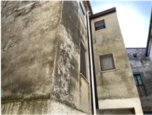
Esterno del fabbricato visto dal retro
