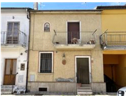
Esterno del fabbricato fronte strada
