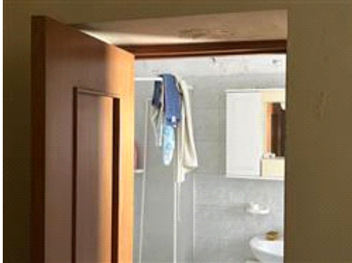
Bagno al piano primo
