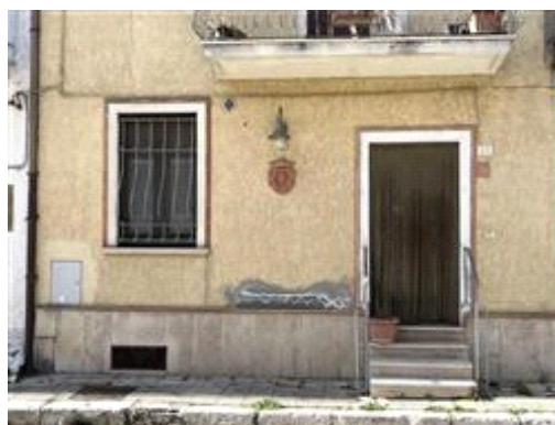
Esterno del fabbricato fronte strada
