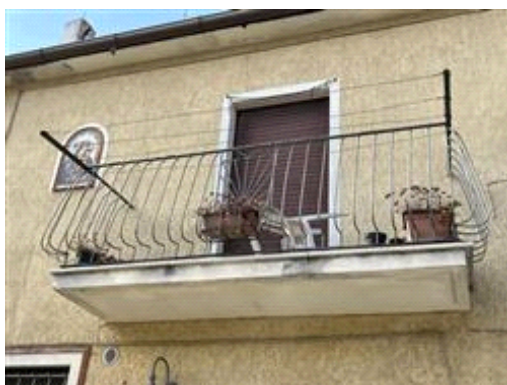
Esterno del fabbricato, particolare del balcone al piano primo
